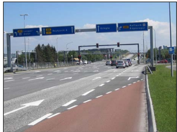
Mynd 11 – Miklabraut- Kringlumýrarbraut horft til austurs
