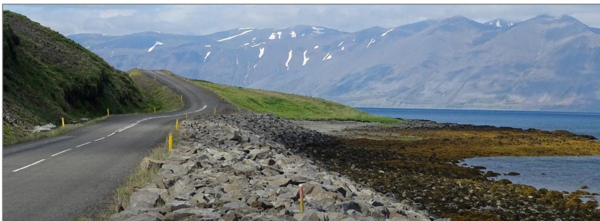
Mynd 34. Kröpp blindhæð skammt norðan Otradals (mynd: SJ, 2016).
