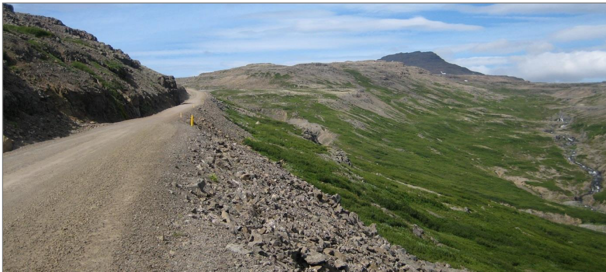
Mynd 13. Vestfjarðavegur um Pennusneiðing (mynd: HA, 2012).
