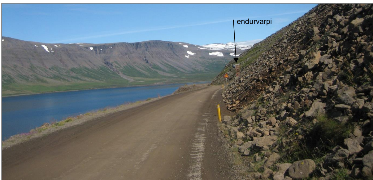
Mynd 32. Vegurinn um Mjólkárhlíð. Endurvarpsstöð í vegkantinum (mynd: HA, 2012).
