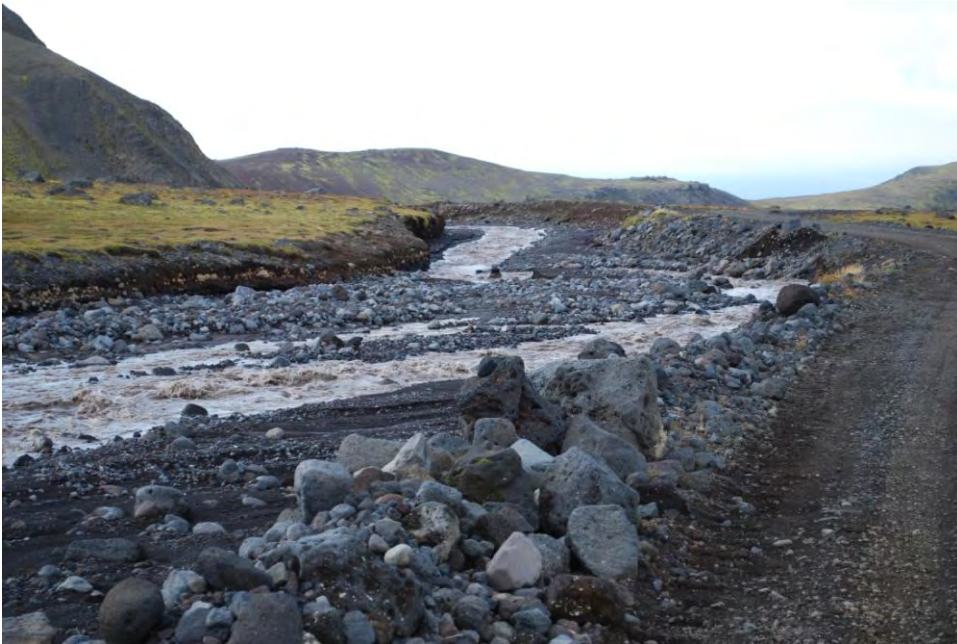
Mynd V 1.9 Rof og skemmdir á vegjöðrum af völdum vatnavaxta í Móðuá/ Hólmkelsá
