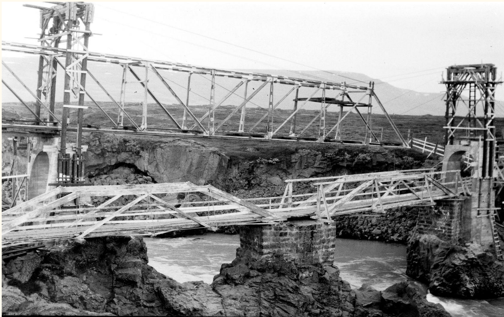
Brú yfir Skjálfandafljót hjá Fosshóli í byggingu.
