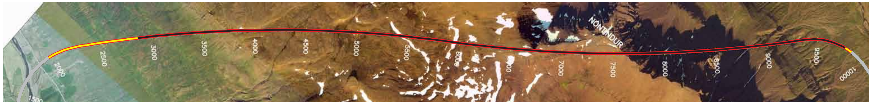
Norðfjarðargöng, staða framkvæmda 17. mars 2014. Búið er að sprengja 940 m sem er 12,5% af heildarlengd.
