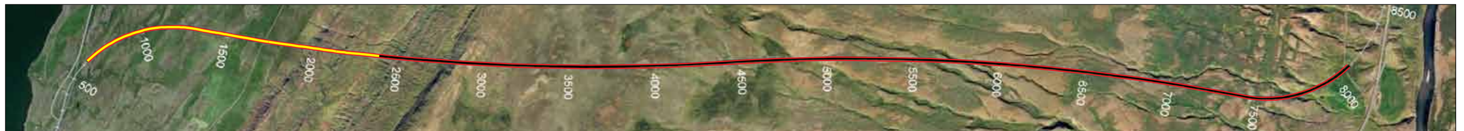
Vaðlaheiðargöng, staða framkvæmda 10. febrúar 2014. Búið er að sprengja 1.776 m frá Eyjafirði sem er 24,8% af heildarlengd.
