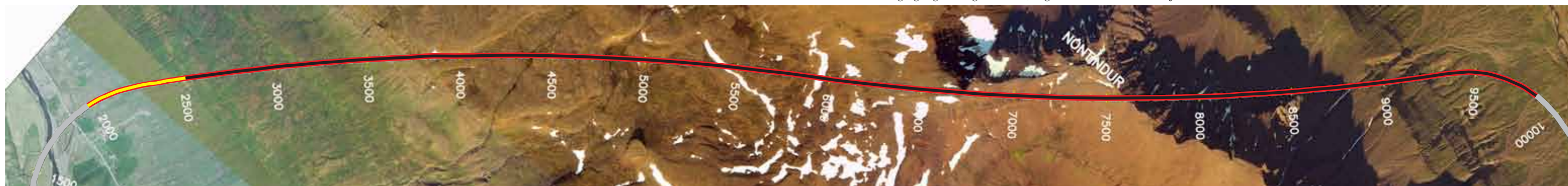
Norðfjarðargöng, staða framkvæmda 10. febrúar 2014. Búið er að sprengja 556 m frá Eskifirði sem er 7,3% af heildarlengd.
