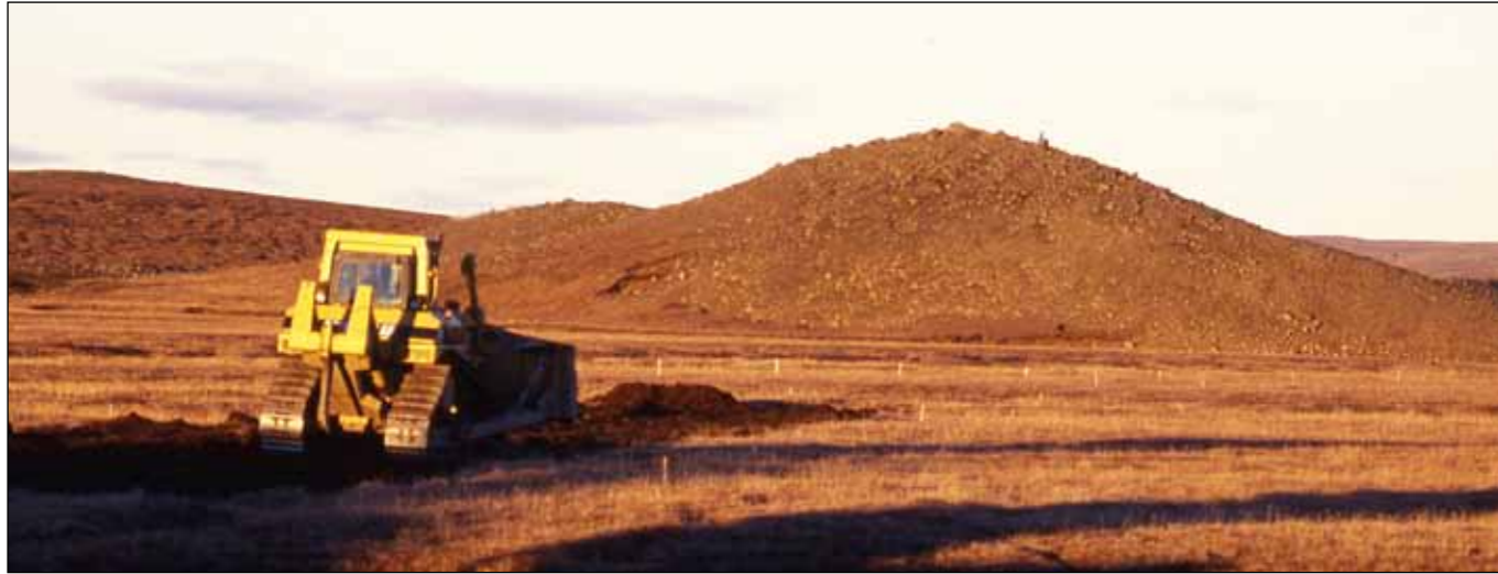
Þann 20. október árið 2000 var nýr vegur um Háreksstaðaleið formlegar vígður. Vegurinn er hluti Hringvegjar (1) á Austurlandi. Verktaki var Arnarfell ehf. Fyrir í mánuðinum hafði Arnarfell ehf. svo gert verksamning um nýtt verk, Norðausturveg (85), Hringvegur - Brunahvammsháls en vesturendi þess vegar var rétt við vinnubúðir flokksins sem var að ljúka við Háreksstaðaleið. Daginn fyrir vígsluna, þann 19. október, lét verktakinn jarðýtu byrja aðeins á nýja verkinu og var það óformlegt upphaf verksins sem vígt var þann 23. október sl., nánast sléttum 13 árum síðar. Myndin á forsiðu þessa blaðs er af sama hluta vegarins en tekin í hina áttina.
