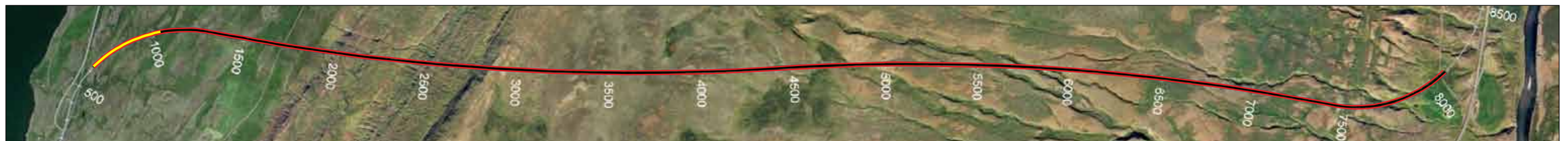
Vadlaheiðargöng, staða framkvæmda 26. ágúst 2013, Búið er að sprengja 423 m frá Eyjafirði sem er 5,9% af heildarlengd.
