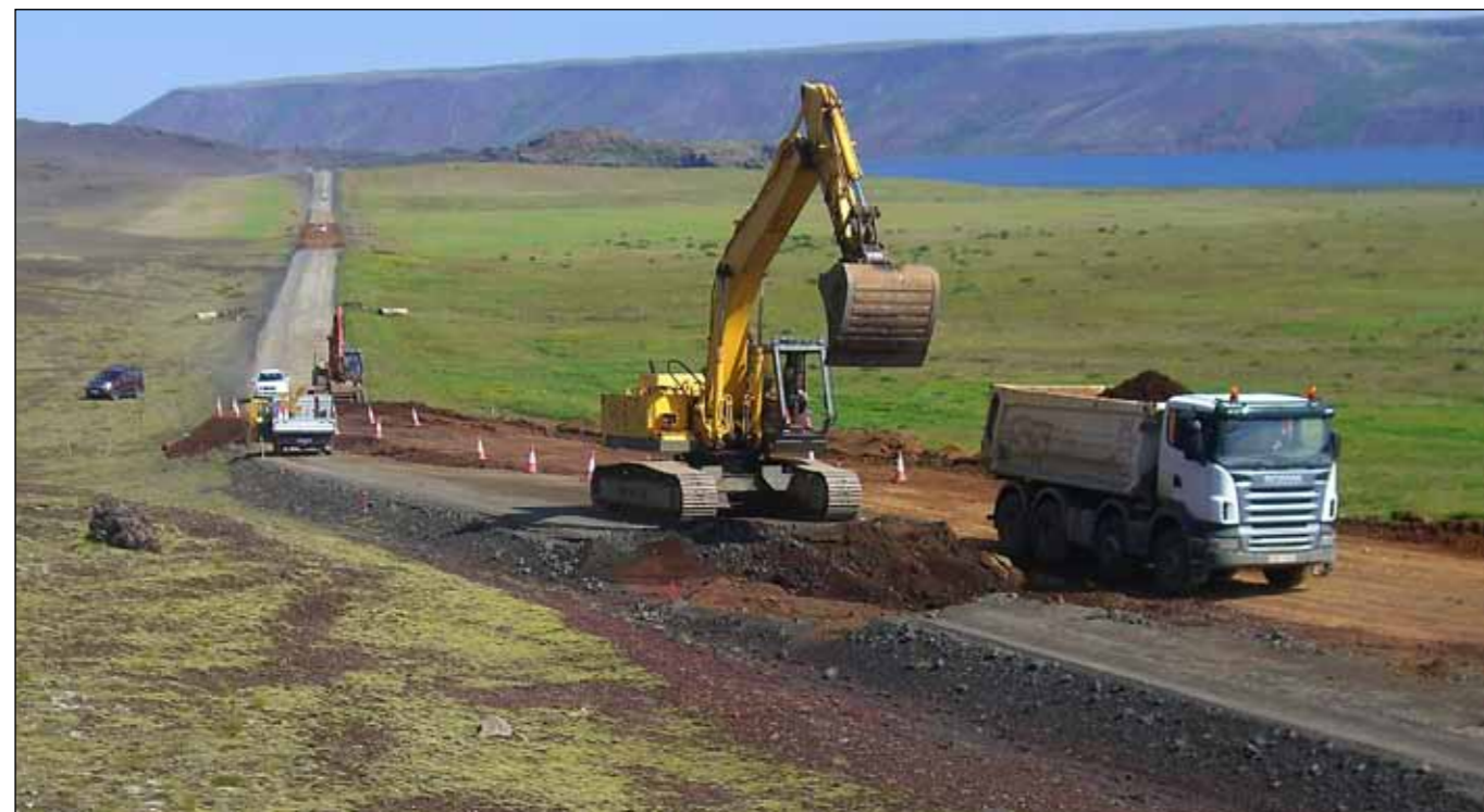
Krýsuvíkurvegur 25. júlí 2013. Endurbættur var 2,2 km kaflí af malarvegi frá Fremra- Nýjalandi að Syðristapa. Nokkur ræsi voru endurnýjuð og síðan var lagt bundið slitlag á kaflann. Ljósmynd: Hilmar Finnsson.
