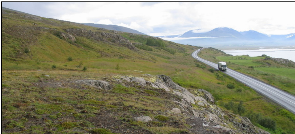
Mynd 32. Vesturmunna Vaðlaheiðarganga er ætlaður staður undir klettinum u.þ.b. þvert til vinstri frá flutningabílnum á þjóðvegi 1. Tenging Svalbarðsstrandarvegar við þjóðveg 1 er áætluð á túnunum aftan við flutningabílinn. Kjarnaborhola VK-05 er staðsett uppi á klettinum lengst til vinstri.
