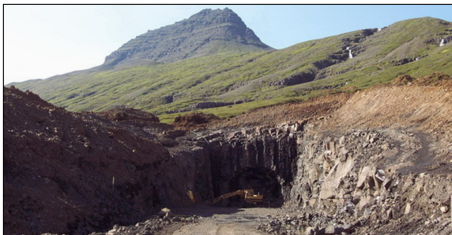
Mynd 42. Talið er að aðstæður við austurmunna Vaðlaheiðarganga við Skóga geti á byggingartíma líkst því sem var við munna í Fáskrúðsfirði við byggingu Fáskrúðsfjarðarganga. Þar var löng gryfja inn að bergvegg.
