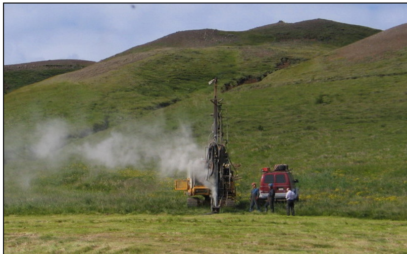
Mynd 39 Loftborun gegnum laus jarðlög og niður í yfirborð bergs við Skóga
