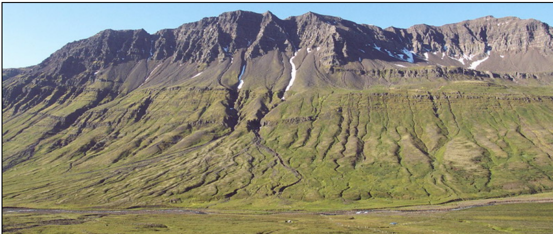
Mynd 2.4. Hólafljall í Fannardal rís bratt móti norðri. Þykkar aurkeilur undir giljum eins og við Tröllagil til vinstri við miðja mynd og flákar úr jökulruðningi (til hægri) setja staðsetningu gangamunna skorður. Áformaður munnastaður Norðfjarðarganga er í vinstri jaðri myndarinnar.
