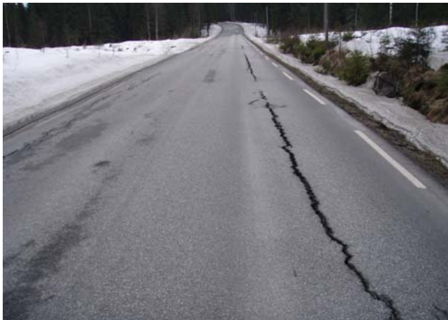
Mynd 3, Tryggja þarf að ekki myndist langsprungur á mótum gamals vegar og breikkunar.
