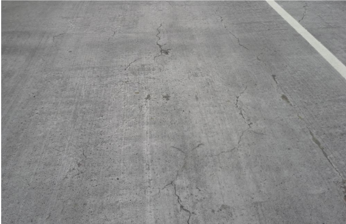
Mynd 49 – Sprungur vegna ónógrar hitastýringar
