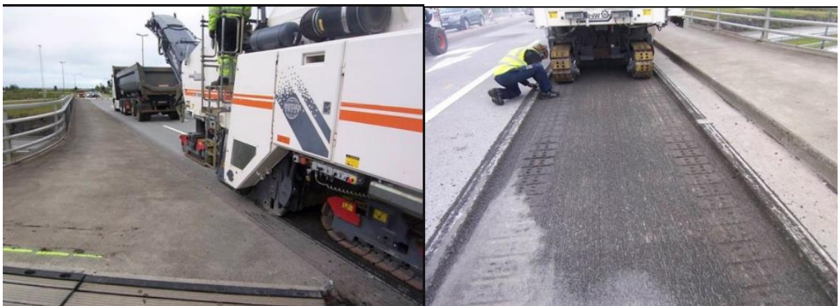
Myndir 23 – unnið að því að fræsa burt ~ 60 mm þykkt lag gamla steypa slitlagsins með malbiksfræsara
