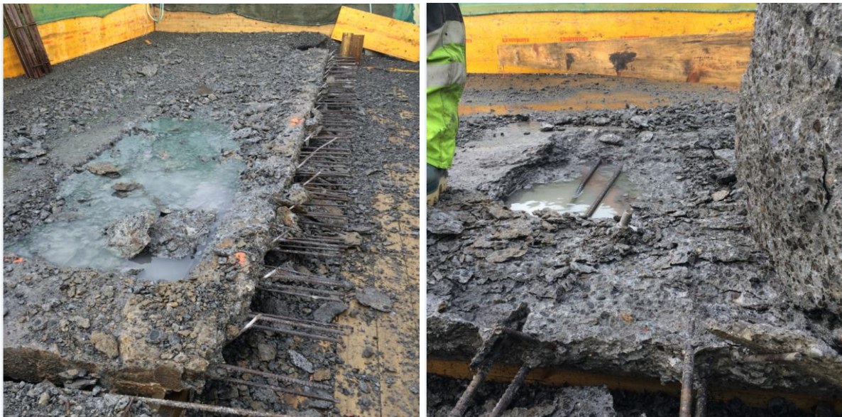
Myndir 16, ófrostþolin steypa, en misjafnt eftir hvar á brúnni
