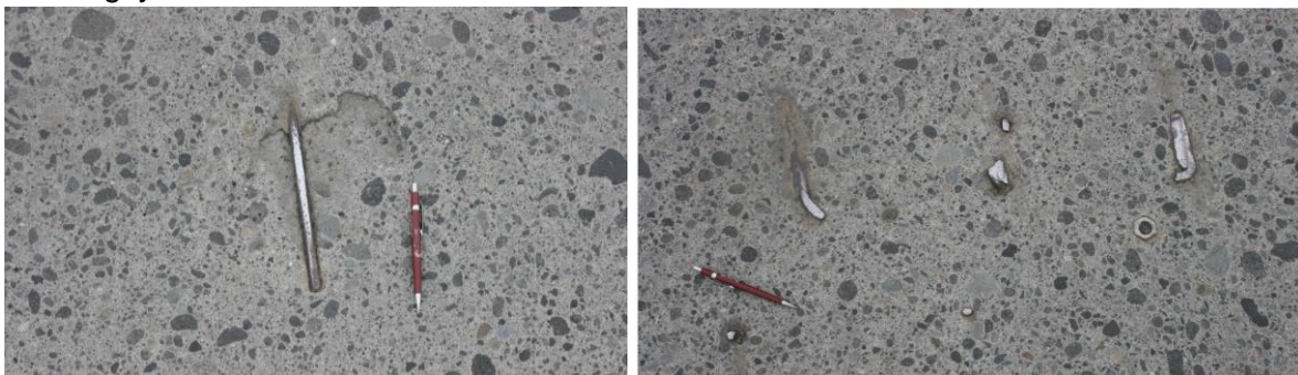
Myndir 4, dæmi um slit í yfirborði – slit komið niður í járnagrind
