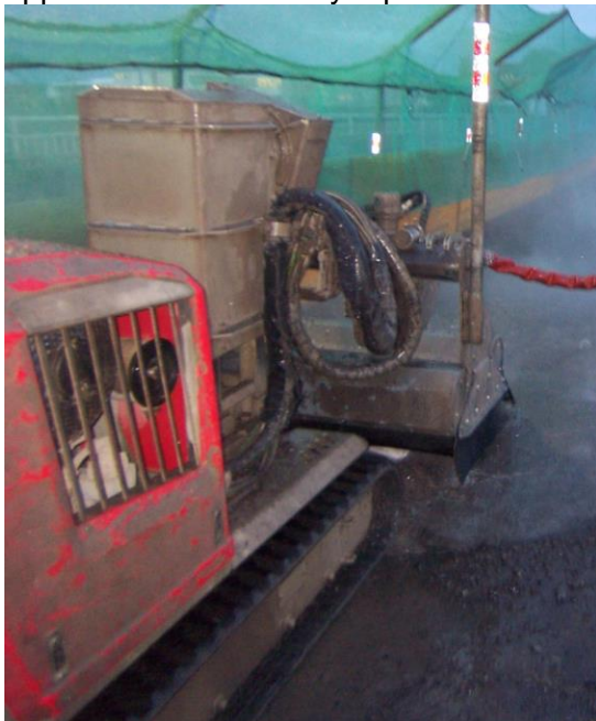
Mynd 3, vatnsbrot í yfirborði Sogsbrúar 2015 og Blöndubrúar 2016
