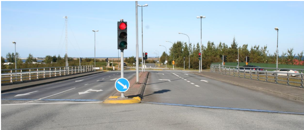
Myndir 22 – slitlag syðstu akreinarinnar, akreinar lengst til vinstri á myndinni var endurnýjað
