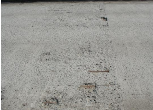
Myndir 9, dæmi um slit / skemmdir í yfirborði
