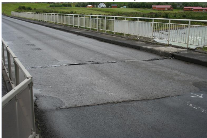
Myndir 15, dæmi um slit / skemmdir í yfirborði
