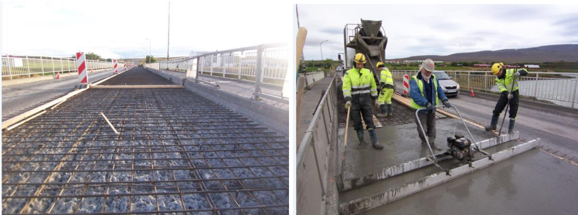
Myndir 17, járngrindin í akrein undan straumi tilbúin – steypu blandað í steypubíl - truckasteypa
