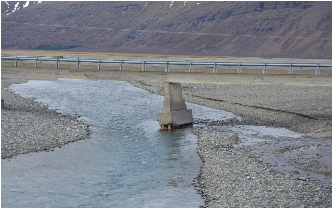
Mynd 4-32: Núverandi ástand millistöpuls 2. Líklegt er að nokkrir af timburstaurunum séu brotnir (Vegagerðin, 2018).
