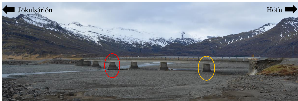
Mynd 4-11: Brúin yfir Steinavötn. Mynd tekin eftir atburð. Sigstöpull er merktur með rauðum hring og millistöpull sem skekkist árið 1966 er merktur með gulum hring (Vegagerðin, 2018).
