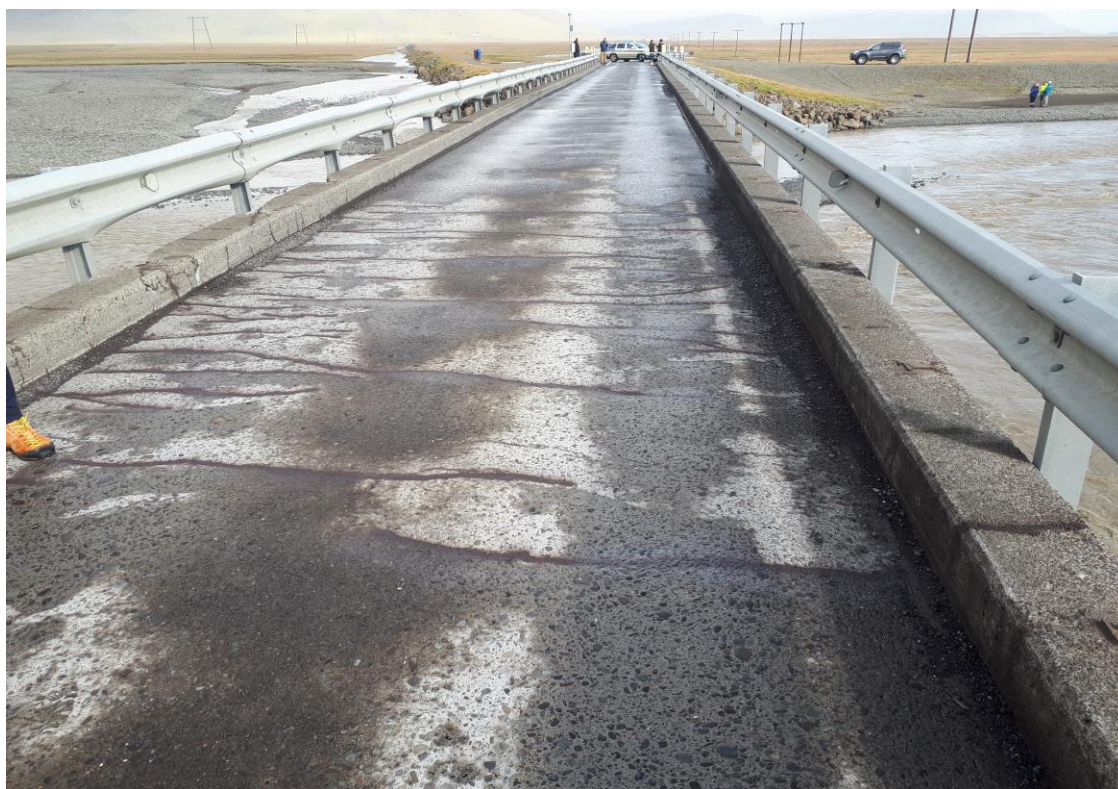
Mynd 4-12: Sprungur gengu 5 metra sitthvoru megin við ásetu á millistöpli 1 og 3.
