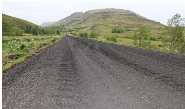
MYND 30 Skálholtsvegur eftir að núverandi vegur var þurrfræstur.
