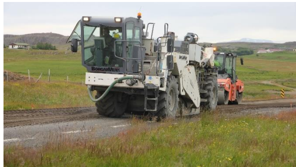
MYND 8 Þurrfræsing er fyrsta skref sementsfestunnar
