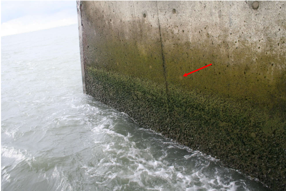
Mynd 2. Óseyrarbrú, stöpull 5. Flögnun í steypunni við meðal fjörumörk. Rauða örin bendir á kónagat.
