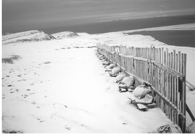
Mynd 9 Auðbjargarstaðabrekka í janúar 1998. Tvær mismunandi útfærslur voru notaðar, lárétt þverbönd hinsvegar og lóðrétt þverbönd annars vegar. (Ljósmynd: Sigurður ...)
