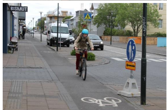
Mynd 3-5: Gula lykilleið hjólréiða á höfuðborgarsvæðinu. Helstu gerðir hjólastígs á leiðinni: 3 m breiður göngu- og hjólastígur í opnu landi (við Elliðaár), 2,5 m breiður hjólastígur meðfram götu (í Mosfellsbæ), 2,5 m breiður hjólastígur (við Steinahlíð), 1,25 m einstefnuhjólarein (á Hverfisgötu).
