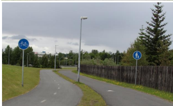
Mynd 3-5: Gula lykilleið hjólréiða á höfuðborgarsvæðinu. Helstu gerðir hjólastígs á leiðinni: 3 m breiður göngu- og hjólastígur í opnu landi (við Elliðaár), 2,5 m breiður hjólastígur meðfram götu (í Mosfellsbæ), 2,5 m breiður hjólastígur (við Steinahlíð), 1,25 m einstefnuhjólarein (á Hverfisgötu).
