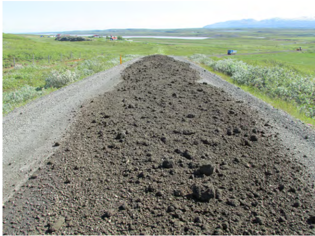
Mynd 8. Malarslitlagsefni keyrt út. Malarslitlagsefni sem er samsett úr tveimur mismunandi efnisgerðum, malaðri mól og finefnum. Efninu var ekki blandað saman í námu heldur var malarefni sett upp á vörubilsþall og finefnin sett þar ofaná. Efnin blönduðust ekki vel saman eins og sést á myndinni heldur eru finefnin ofaná mólinni. Mynd: Hafðís Eygló Jónsdóttir 2019.
