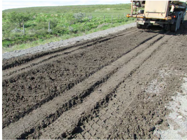
Mynd 9. Malarslitlagsefni keyrt út. Sama efni og í mynd 8. Hér sést hversu mikið efnið sporast sökum of mikilla finefna. Mynd: Hafðís Eygló Jónsdóttir 2019.
