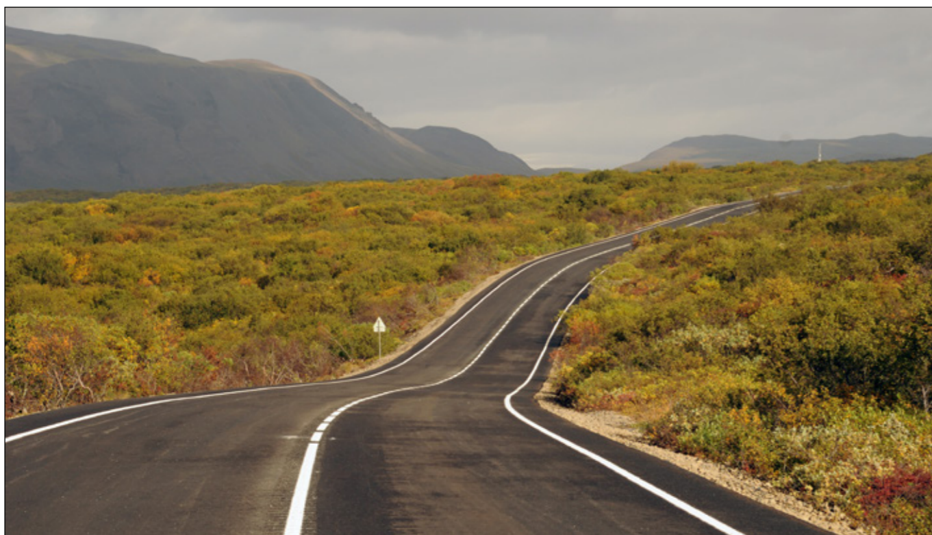
Plan- og hæðarlega Þingvallavegar er óbreytt þrátt fyrir endurbætur. Sjónlengdir eru því víða takmarkaðar og framúrakstur óeskilegur. Mikilvægt er að ökumenn virði hámarkshraðatakörkun 50 km/klst.
