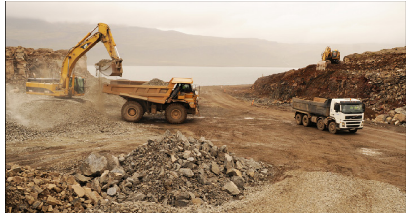
Vestfjarðavegur (60), Kjálkafjörður – Vatnsfjörður, framkvæmdir 2014.
