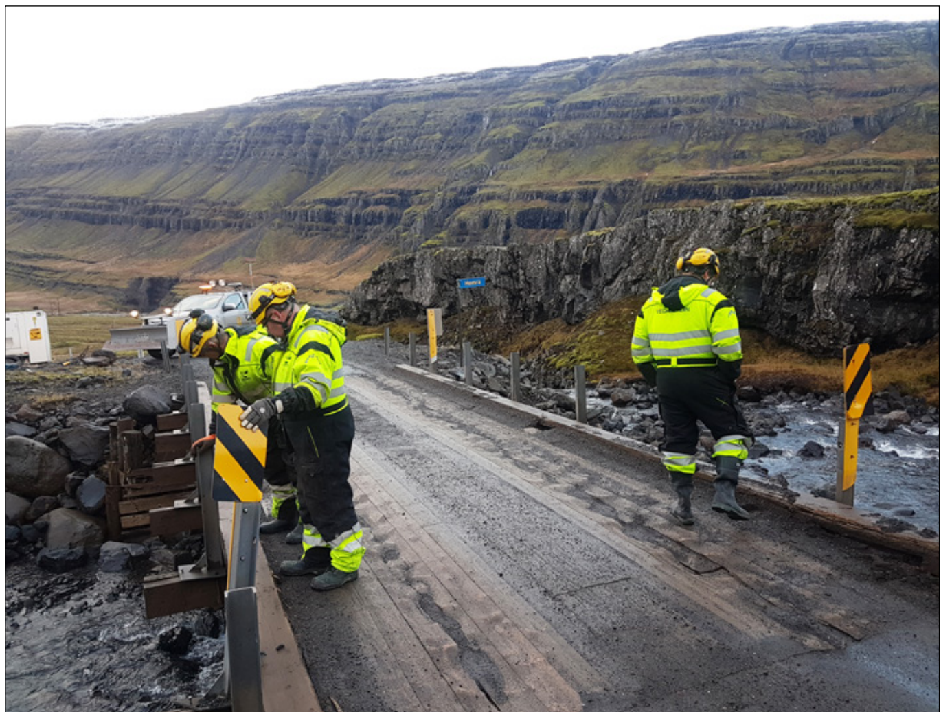
Axarvegur (939), brúarvinnuflokkur Vegagerðarinnar frá Vík skipti um stálbita og gólf á brúnni yfir Hemru 13. nóvember 2018. Ljósmynd: Þorleifur Olsen.
