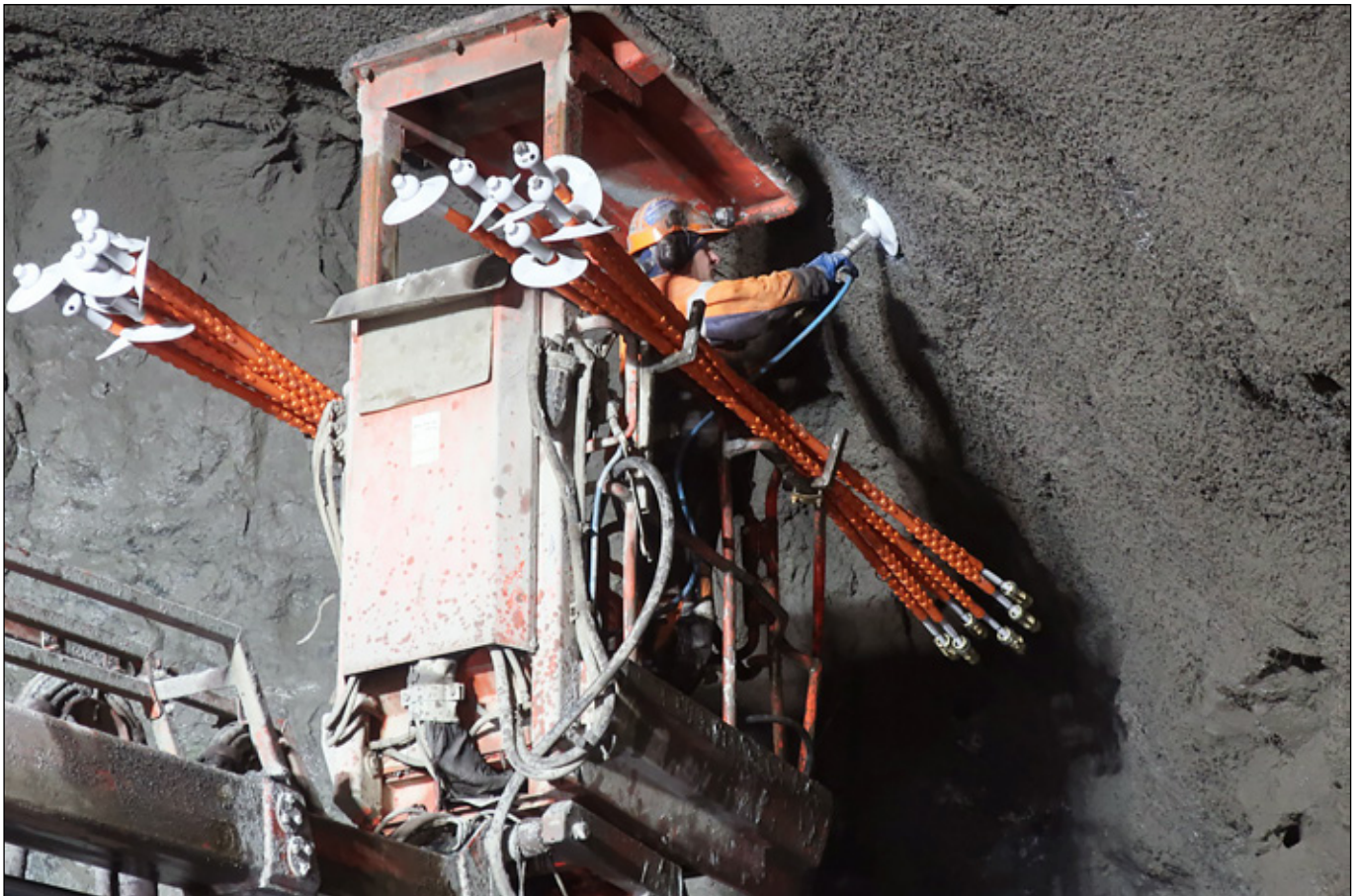
Dýrafjarðargöng, bergboltar settir upp 7. nóvember 2018.
