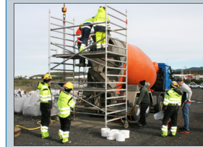
Steypa blönduð í steypubíl við Blöndubríu.
