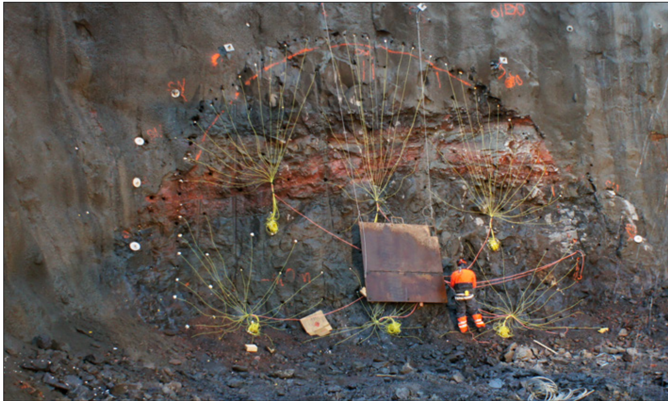
Undirbúningur sprengingar í stafni í Eskifirði 12. nóvember 2013.
