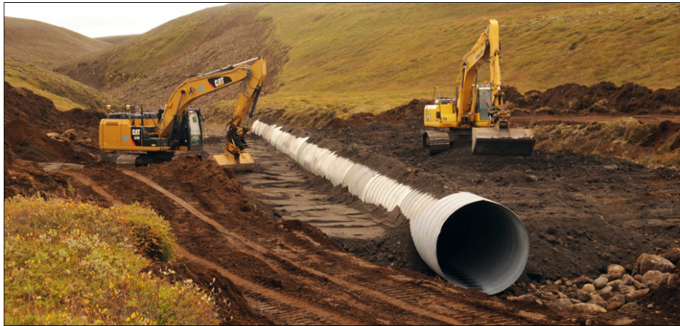
Dettifossvegur (862), ræsi rúmlega 90 m langt lagt undir vegfyllingu 12. september 2017.
