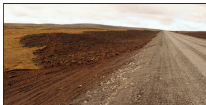
Svæðið fremst á myndinni hefur verið gróðurlaust við upphaf vegagerðarinnar en síðan tekur við svæði þar sem svarðlag hefur verið varðveitt og lagt út að nýju. Það er gert eins fljótt og hægt er eftir að mynd er komin á veginn. Eftir er að leggja út burðarlag vegarins og bundið slitlag.
