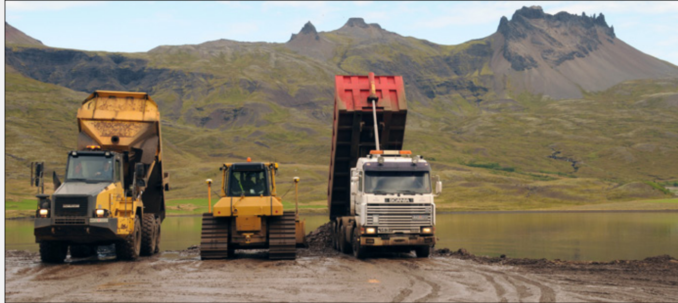
Unnið við fyllingu yfir fjörðinn.
