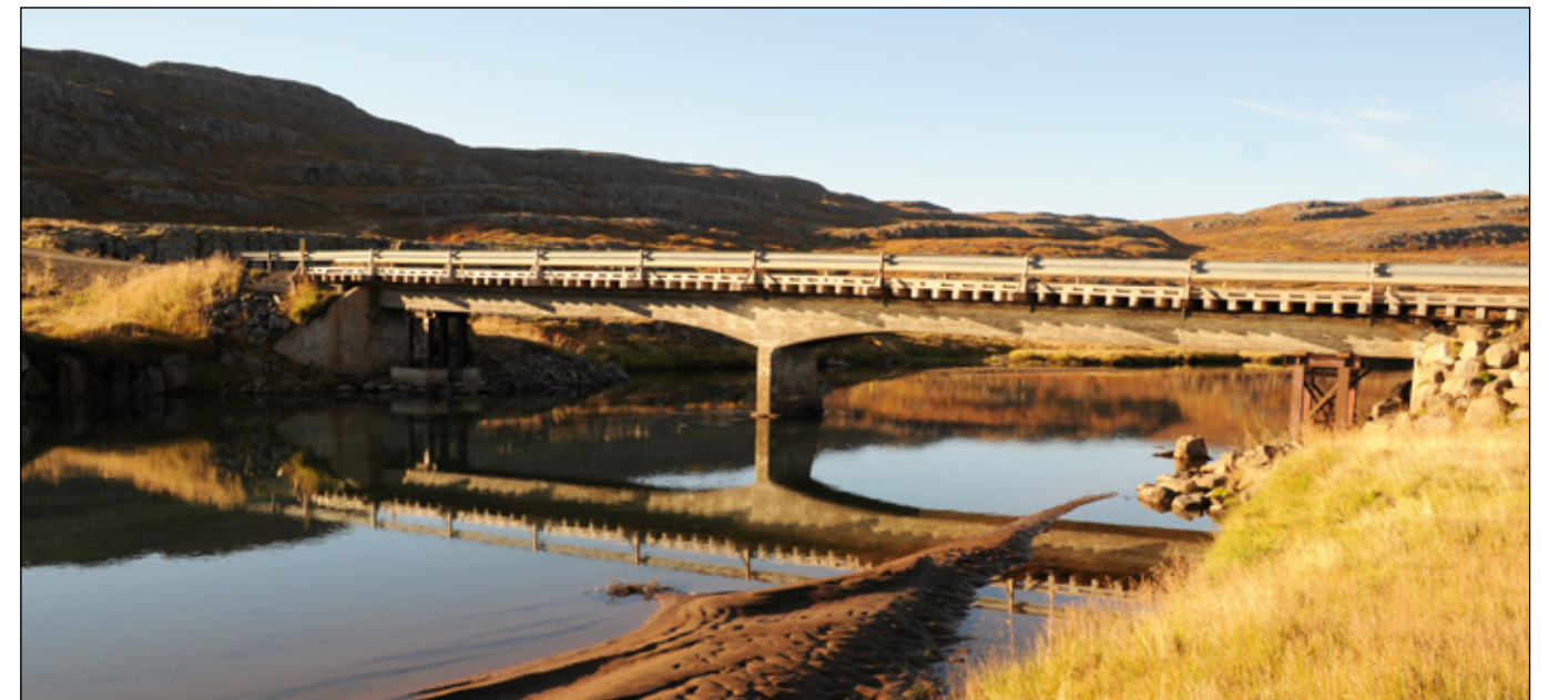
Núverandi brú á Bjarnarfjarðará er orðin lúin og hafa stálundirstöður verið settar framan við endastöpla.
