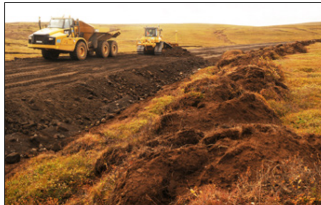
Fyllingarefni ekið úr námu. Til hliðar við veg eru hraukar af svarðlagi sem bíða þess að verða settir á vegfláa.
