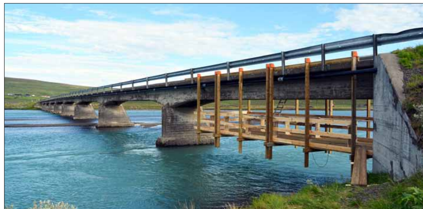
Brúin á Skjálfandafljót á Norðausturvegi (85) hjá Skriðuvaði. Verkpallar vegna styrkingar.
