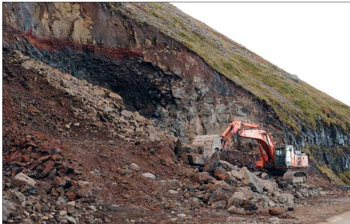
Framkvæmdir í Súðavíkurlíð 27. september 2016. Sjá niðurstöður útboðs.
