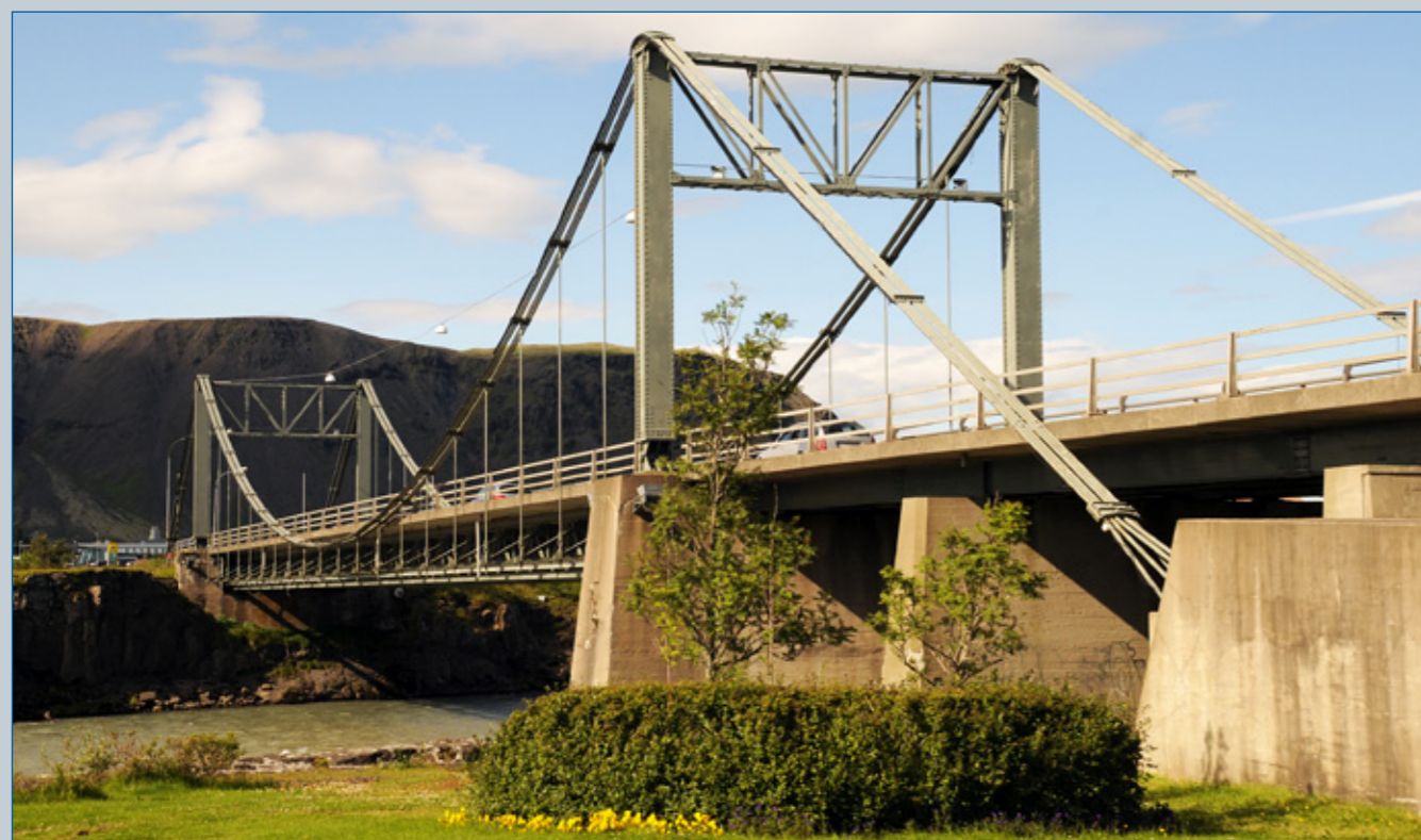
Hengibrúin yfir Ölfusá er til umfjöllunar í skýrslu um vöktunarkerfi.
