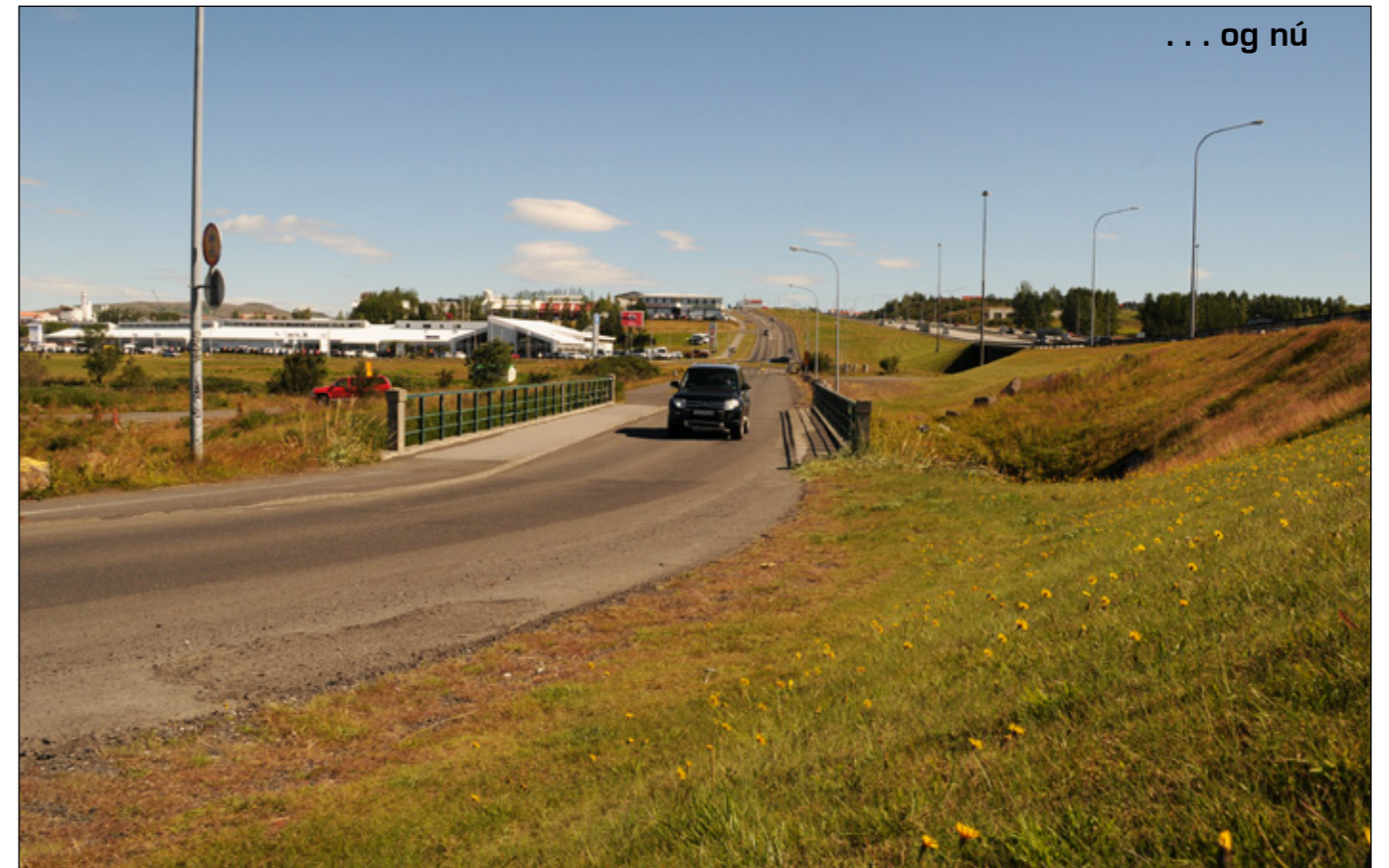
Eldri myndin er úr safni Geirs G. Zoëga og er árssett 1947. Hún er hluti myndaraðar sem sýnir ástand á steypu vegyfriborði „Ellidaárvegur“ en það hefur verið heiti þess vegar sem nú er Suðurlandsbraut og framhald hans að Ellidaám. Brýrnar voru byggðar 1941. Yngri myndin er tekin í ágúst 2016. Vegur upp Ártúnshrekkju og brýr sem sjá má til hægri á yngri myndinni eru frá 1970.
