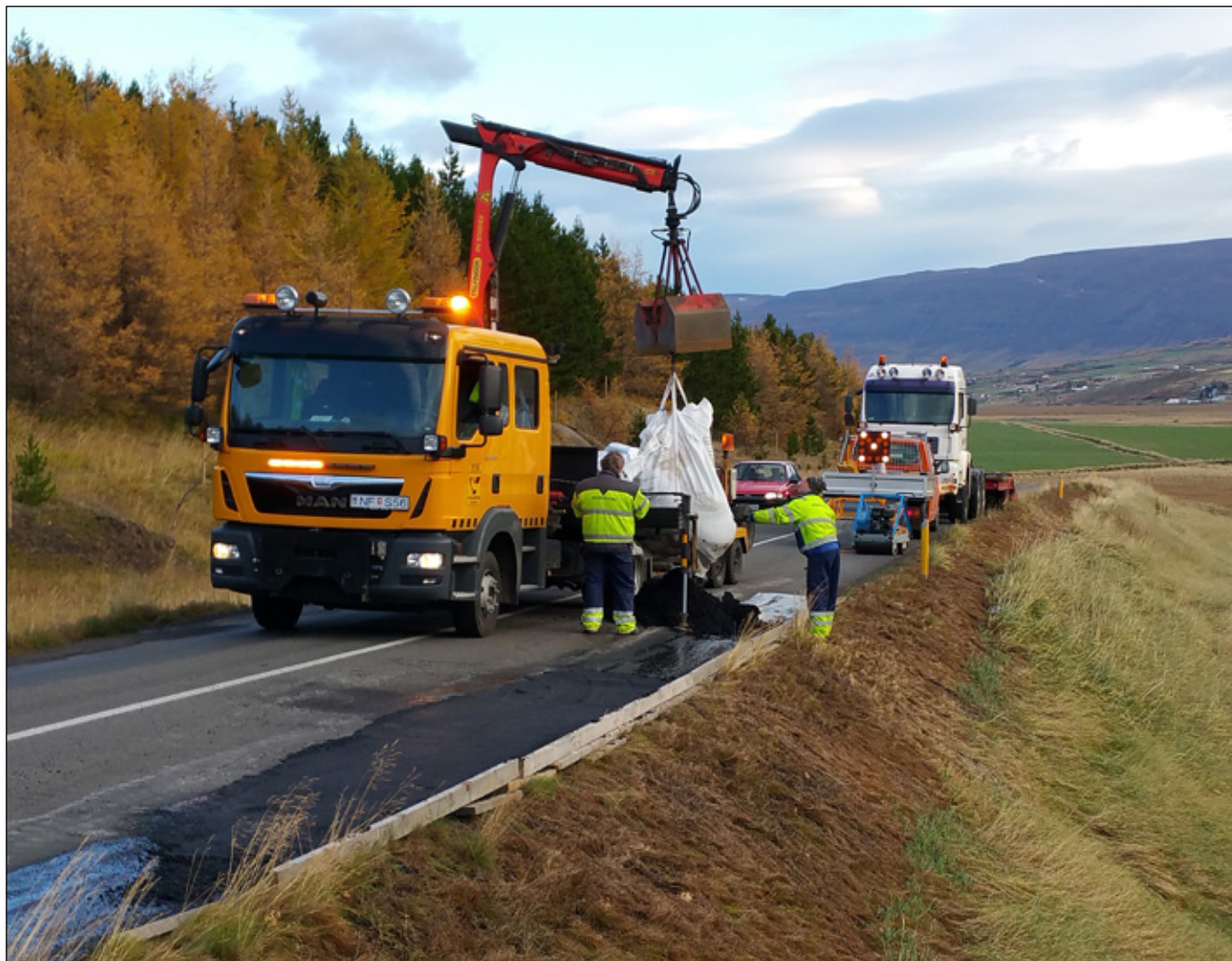
Slitlagaviðgerð á Eyjafjarðarbraut vestri (821) við bæinn Espihól 14. október 2015. Starfsmenn þjónustustöðvar Vegagerðarinnar á Akureyri að störfum.
