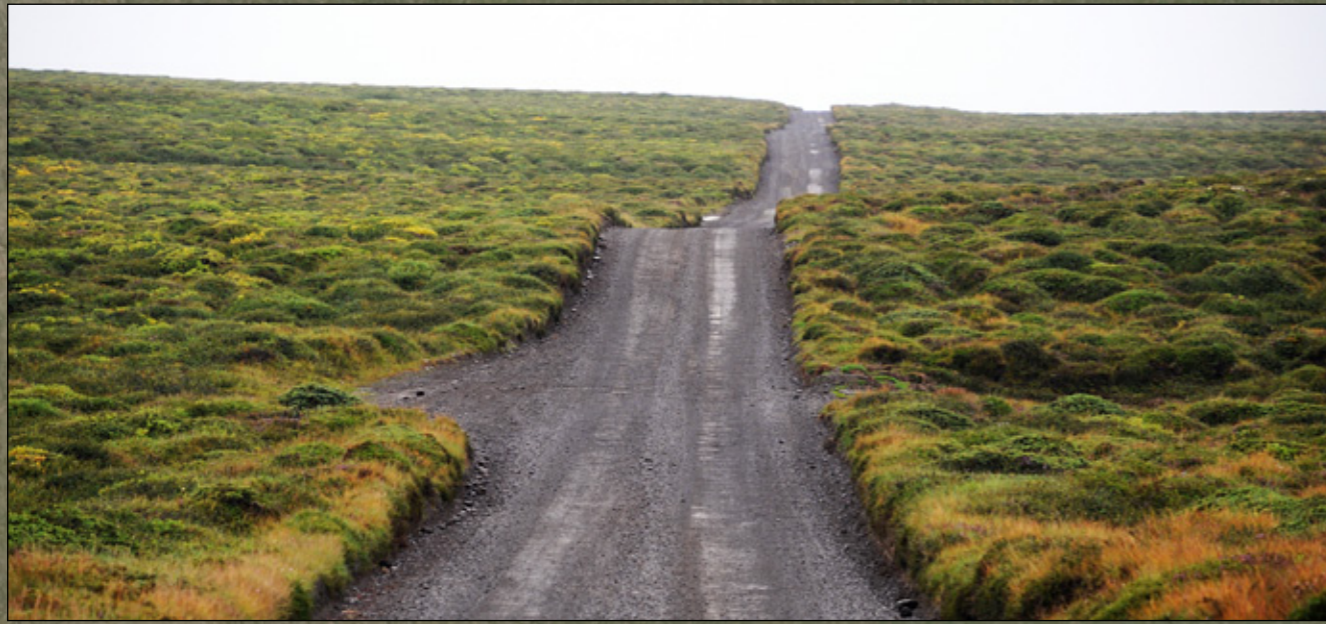
Núverandi Dettifossvegur að norðanverðu. Þegar kaflinn sem nú er í útboði verður tilbúinn eru um 17 km eftir af svona vegi sem þarf að endurbyggja. Við vegagerðina er gróðurtorfan (svarðlagið) sérstaklega tekin frá og notuð til að þekja vegfláann í verklok.
