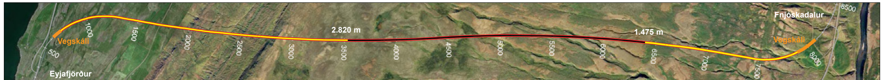
Vaðlaheiðargöng, staða framkvæmda 29. júní 2015. Búið er að sprengja samtals 4.295 m sem er 59,6% af heildarlengd.
