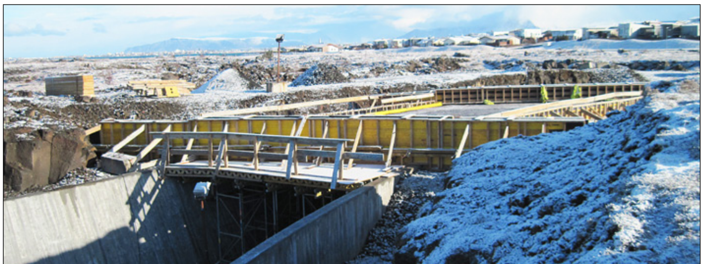
Álftanesvegur, undirgöng í byggingu 23. mars 2015.
