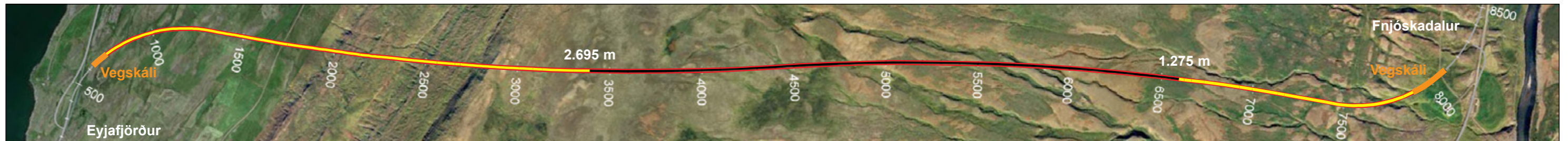
Vaðlaheiðargöng, staða framkvæmda 23. mars 2015. Búið er að sprengja samtals 3.970 m sem er 55,1% af heildarlengd.
