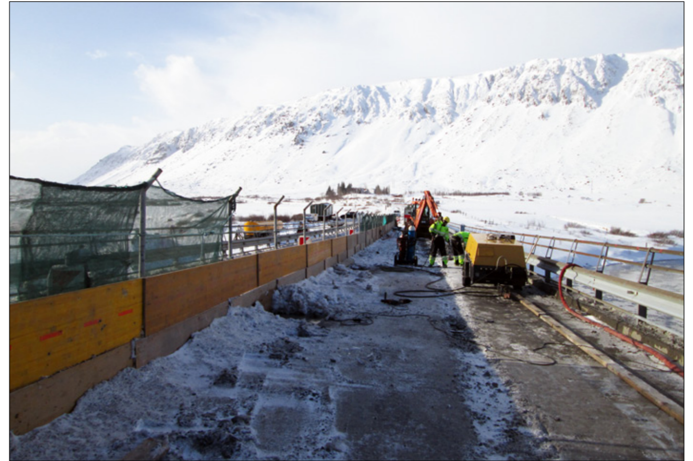
Biskupstungnabraut (35), brúin yfir Sogið hjá Prastalundi í Grímsnesi. Þar er nú unnið að endurnýjun á yfirborði yfirbyggingar.
