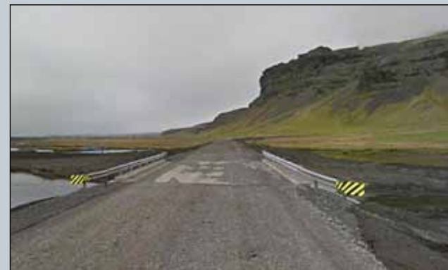
Ný brú yfir Aurá áður en bundið slitlag var lagt á veginn.
