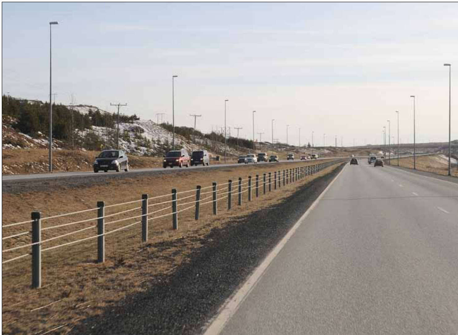
Efst á síðunni hér til vinstri er útbodsauglýsing fyrir víravegríð á 6,6, km langan kafla á Reykjanesbraut. Á myndinni má sjá víravegríð á milli akreina á Hringvegi (1), Vesturlandsvegi, milli Reykjavíkur og Mosfellsbæjar. Boðið er út sambærilegt víravegríð en bjóða má aðra útfærslu á víravegríði.
