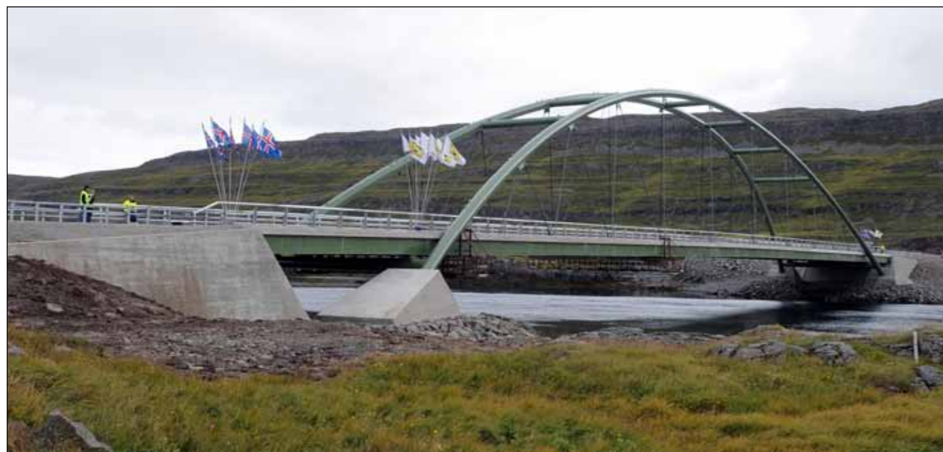
Brú yfir Mjóáfjörð er hluti verksins, Djúpvegur, Reykjanes - Hörtná. Myndin er tekin á vágsludegi 3. september 2009.
