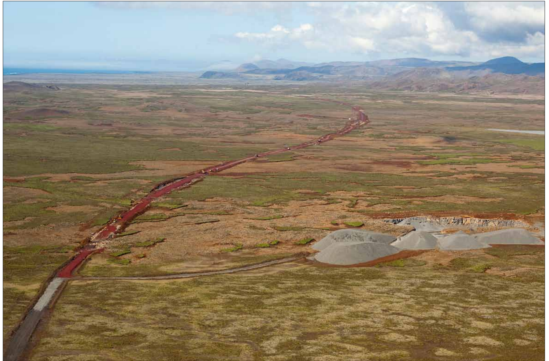
Suðurstrandarvegur í júlí 2011. Mynd: Mats.
