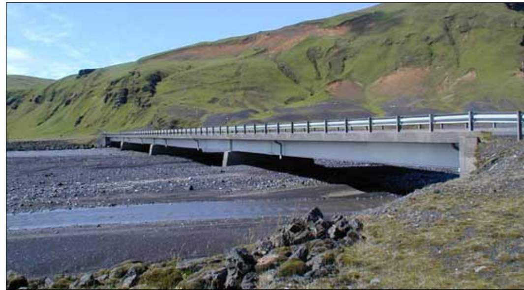
Múlakvísl. Brúin frá 1990 sem jökulhlaupið eyðilagði. Upphaflega var vatnsopið þrjár metrar á hæð en fljótið breytti síðan hegðun sinni og tók að hlaða upp efni í farveginum. Mynd frá 2007.
