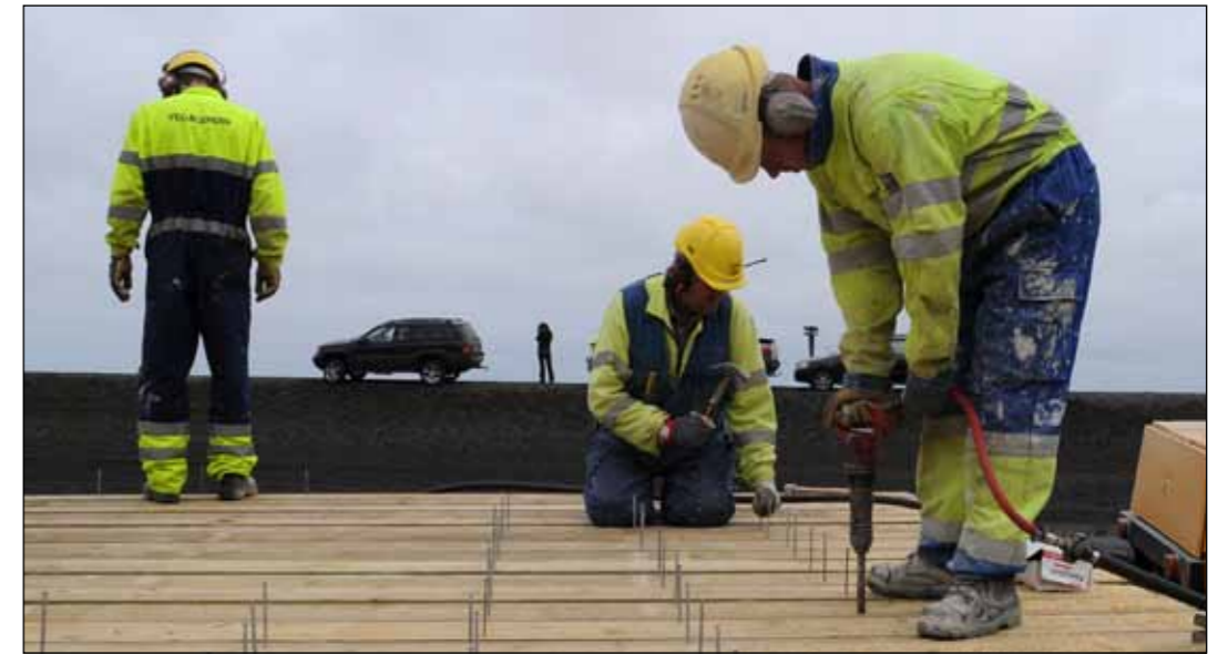
Múlakvísl. Einingar af brúardekki settar saman á landi. Smiður tillir nöglunum sem eru síðan reknir niður með loftverkfæri.
