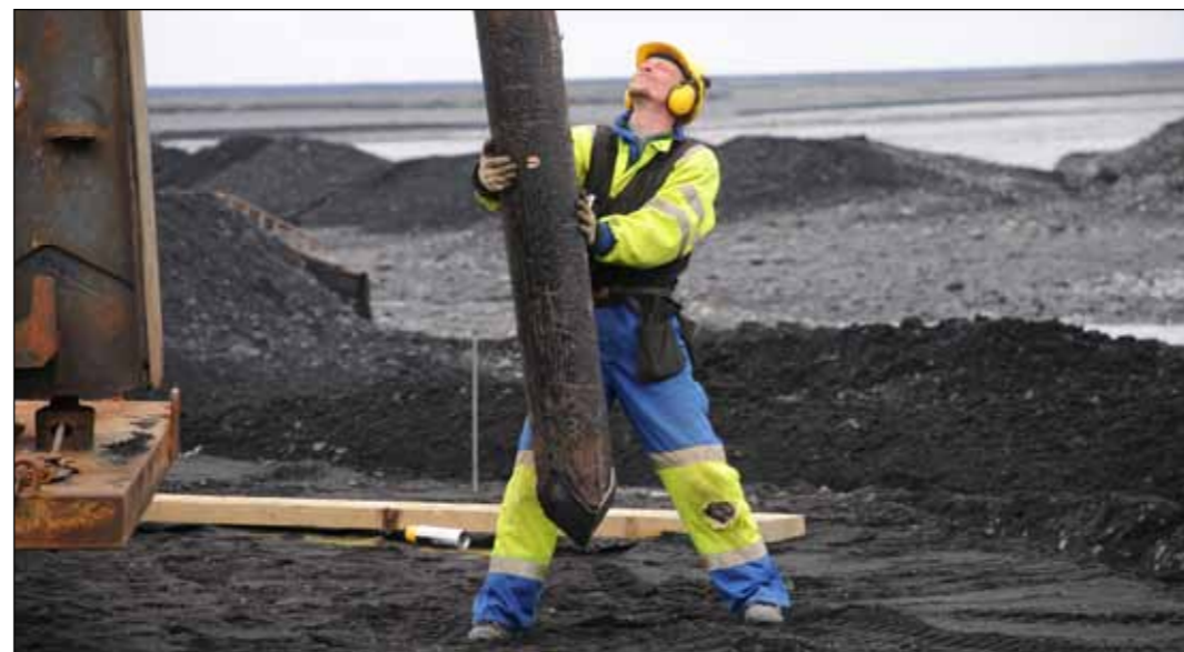
Niðurrekstur staura fyrir undirstöður. Staurinn stilltur af fyrir hamarinn.
