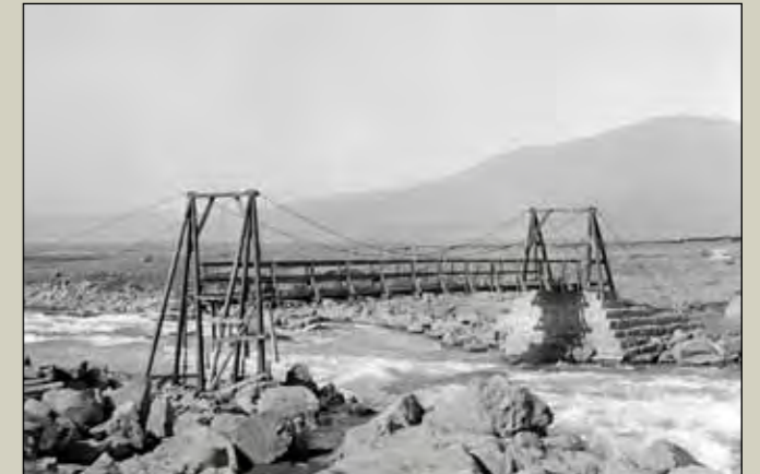
Tungufljót á Geysisvegi. Göngubrú
