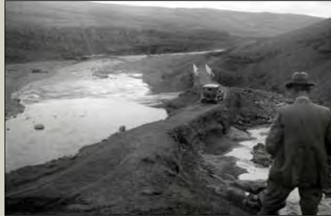
Ekið yfir brúna á Kattarhryggsgili á suðurleið, Norðurá vinstra megin
