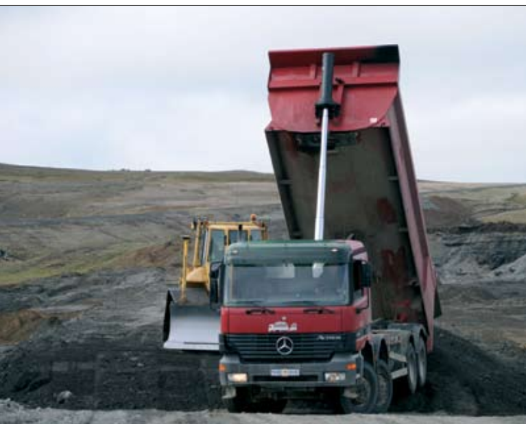
Framkvæmdir við Hringveg (1) í Jökuldal 4. september 2008. Verktaki: Héraðsverk ehf.
