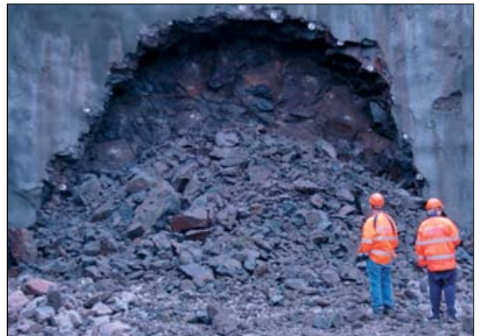
Gangamunninn eftir fyrstu sprengingu.
