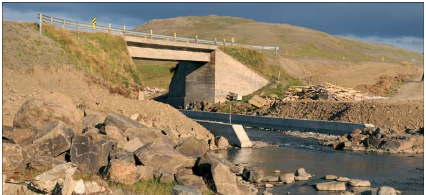
Vestfjarðavegur (60) í Miðdölum. Tunguá sett í stökk í stað einbreiðrar brúar. Myndin er tekin 8. ágúst 2008.
