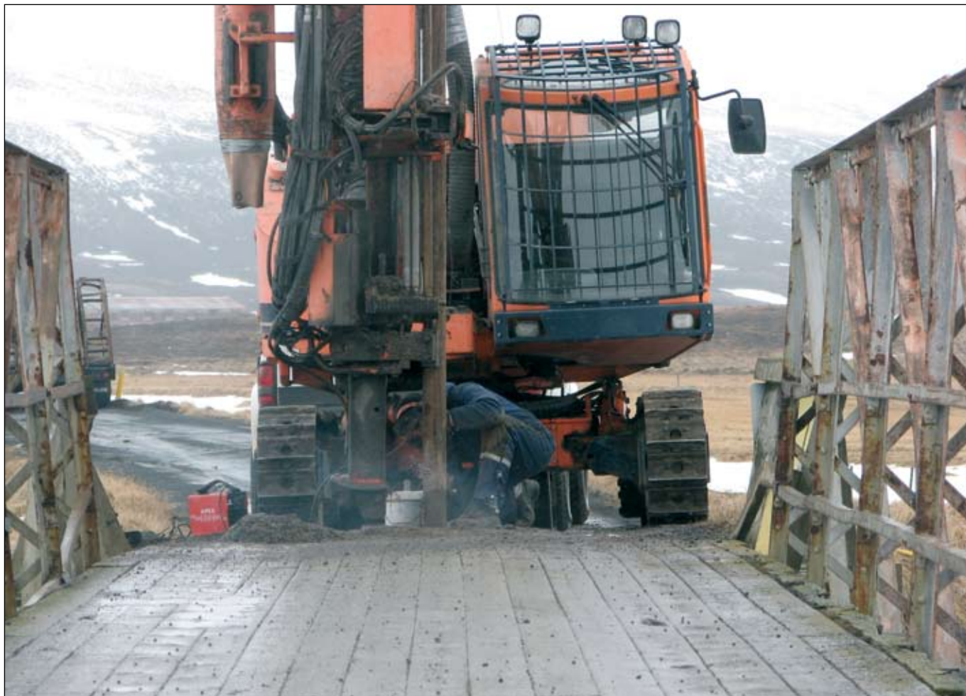
Jarðvegsathugun vegna væntanlegrar brúargerðar yfir Reykjadalssá við Akra á Austurhlíðarvegi (846). Tamrock borvagn. Unnið að því að sjóða saman fóðringar. Mynd: Hafdís Eygló Jónsdóttir, 02.05.2008
