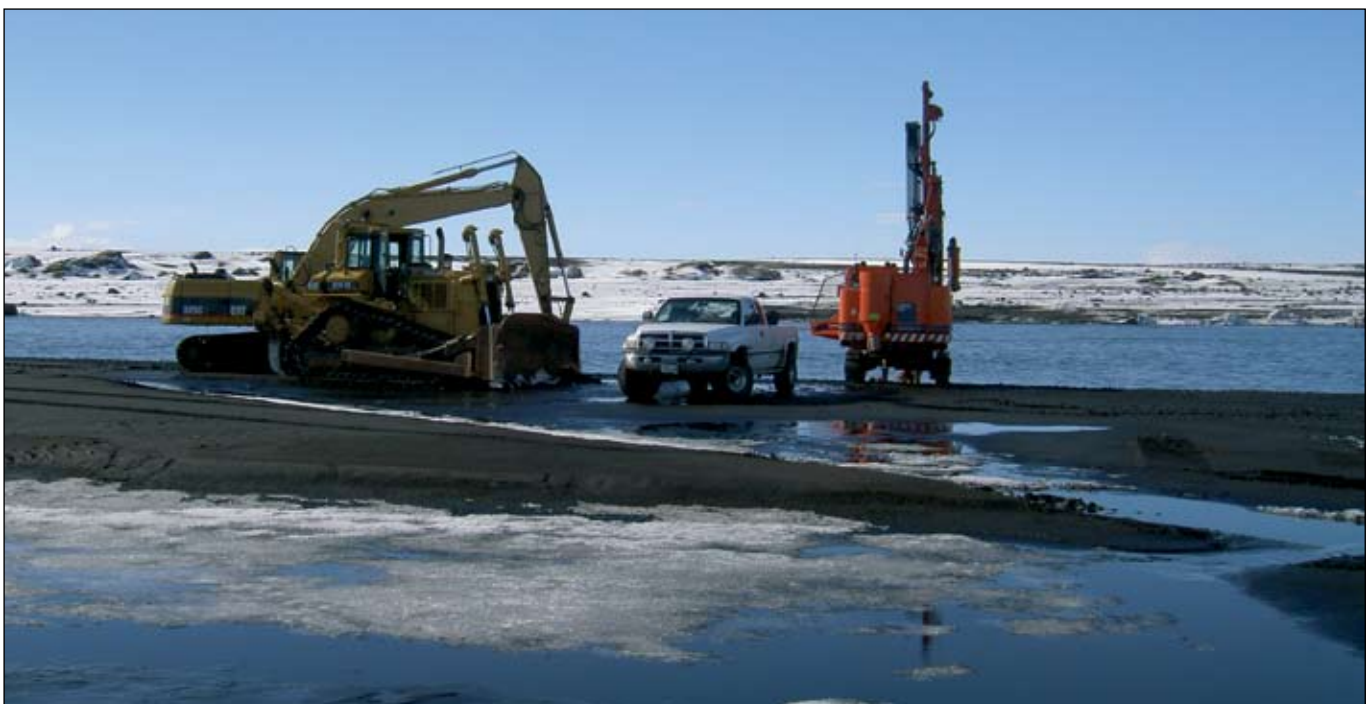
Jarðfræðirannsóknir við nýtt brúarstæði Jökulsár á Fjöllum 11. apríl 2006. Mynd: Hafdís E. Jónsdóttir
