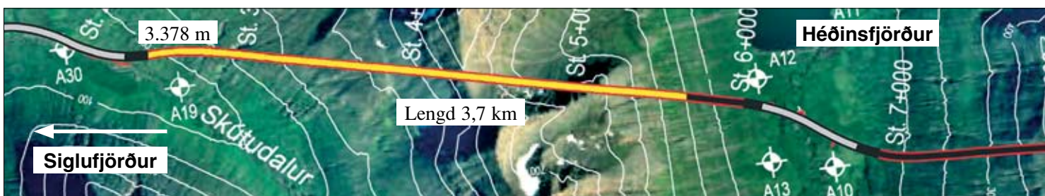
Staða framkvæmda við Héðinsfjarðargöng 4. feb. 2008. Búið er að sprengja 3.378 m í Siglufirði og 2.531 m í Ólafsfirði.
