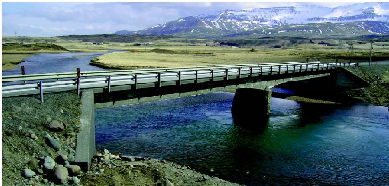
Gamla brúin yfir Andakilsá sem byggð var 1930. Hún er í þökkalegu ástandi og hafa komið upp hugmyndir um að láta hana standa fyrir reiðmenn. Þá má endurnýja handrið með sama útliti og í upphafi.
