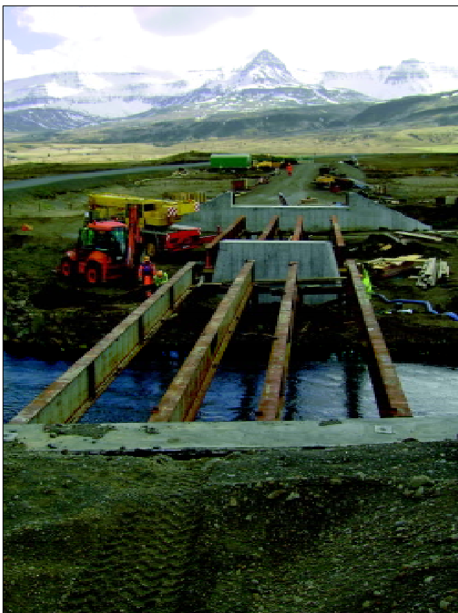
Andakílsá. Stálbitarnir eru undirsláttur fyrir yfirbygginguna.
