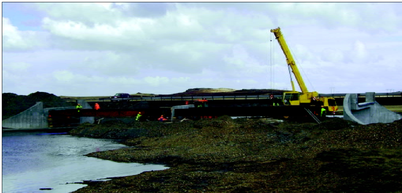
Brúaflokkur Vegagerðarinnar frá Hvammstanga að störfum við Andakílsá.
