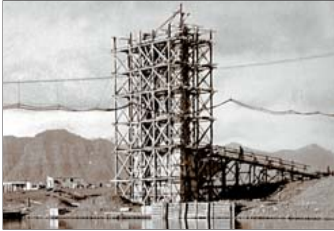
Jökulsá. Eystri turn hengibrúarinnar í byggingu (1966). Í forgrunni er strengurinn með olíuleiðslunni hangandi í, sem segir frá í greininni. Mynd fengin hjá Þorgerði Þorleifsdóttur.
