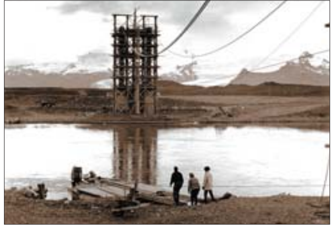
Jökulsá. Vestari turn séður frá austurbakkanum (1967). Byrjað er að draga burðarstrengina yfir ána. Í forgrunni er bryggja og bátur viðliggjandi. Mynd fengin hjá Þorgerði Þorleifsdóttur.
