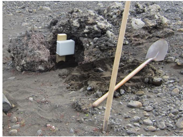
3. mynd. Bifreiðateljara komið fyrir í vegkanti.
