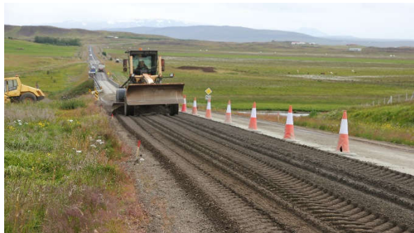
MYND 3 Heflun efnisins um leið og blöndun þess er lokið
