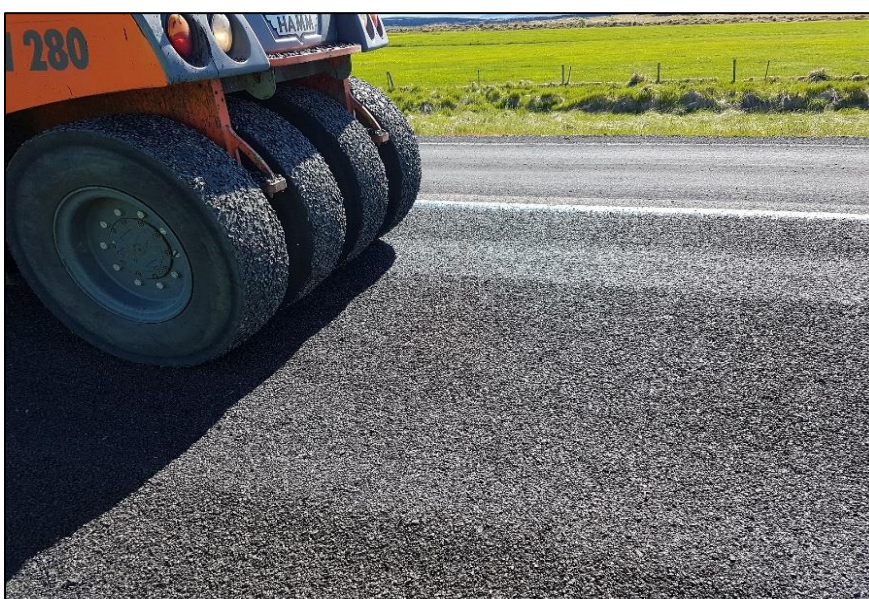
Mynd 9 Steinefni klístrast við gúmmíhjól valta í sólinni
