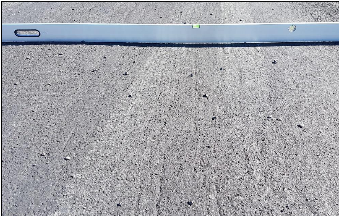
Mynd 10 Réttsskeiðinni brugðið beint á ralumac afréttingu áður en klæðing var lögð á hana
