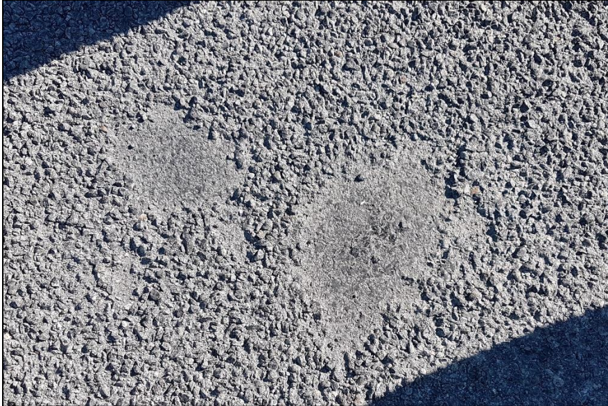
Mynd 5 Skellur á kafla 1-g8 tveggja daga gamall og sópaður
