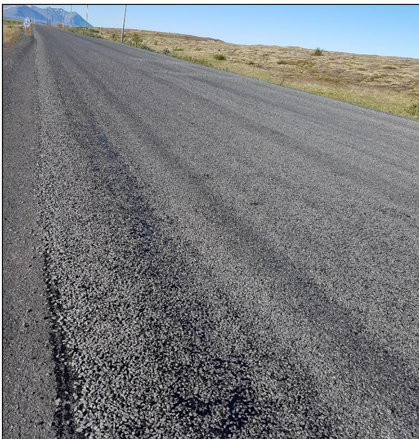
Mynd 8 Bindiefni á yfirborði í kanti hægri akreinar á 1-h0 við stöð 433
