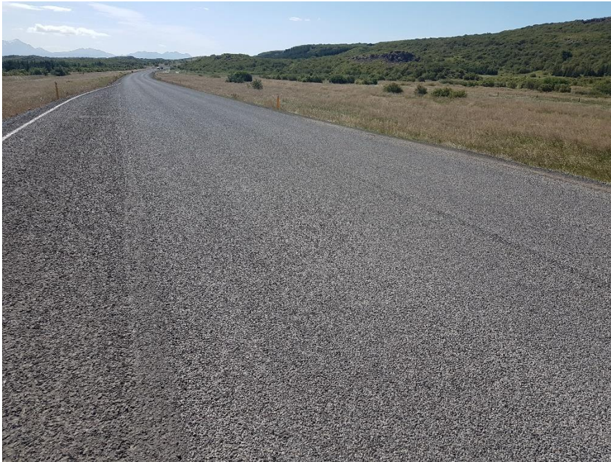
Mynd 6 Kaflinn á 1-h0 tveggja daga gamall og sópaður
