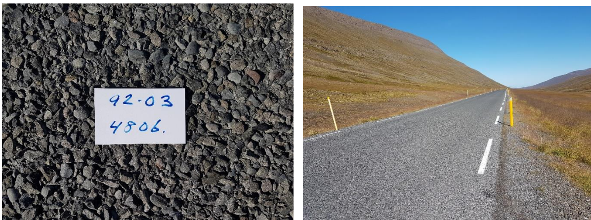
Mynd 17 a) og b) Bikþeytuklæðing við úttekt 30. ágúst 2017 á kafla 92-03, stöð 4806
