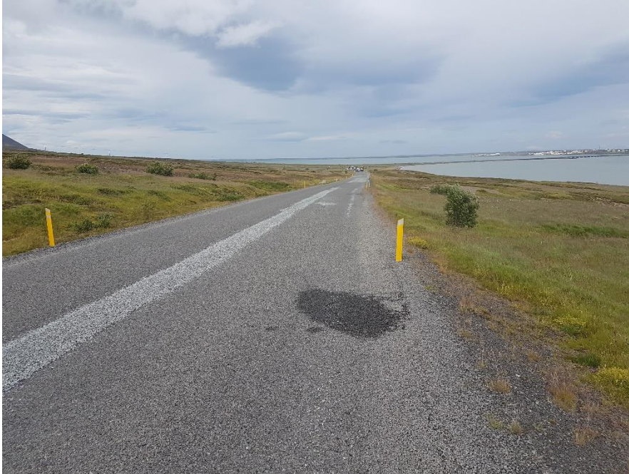
Mynd 9 Viðgerðir á bikþeytukafla með steinefni úr Hólabrú með Durasplitti
