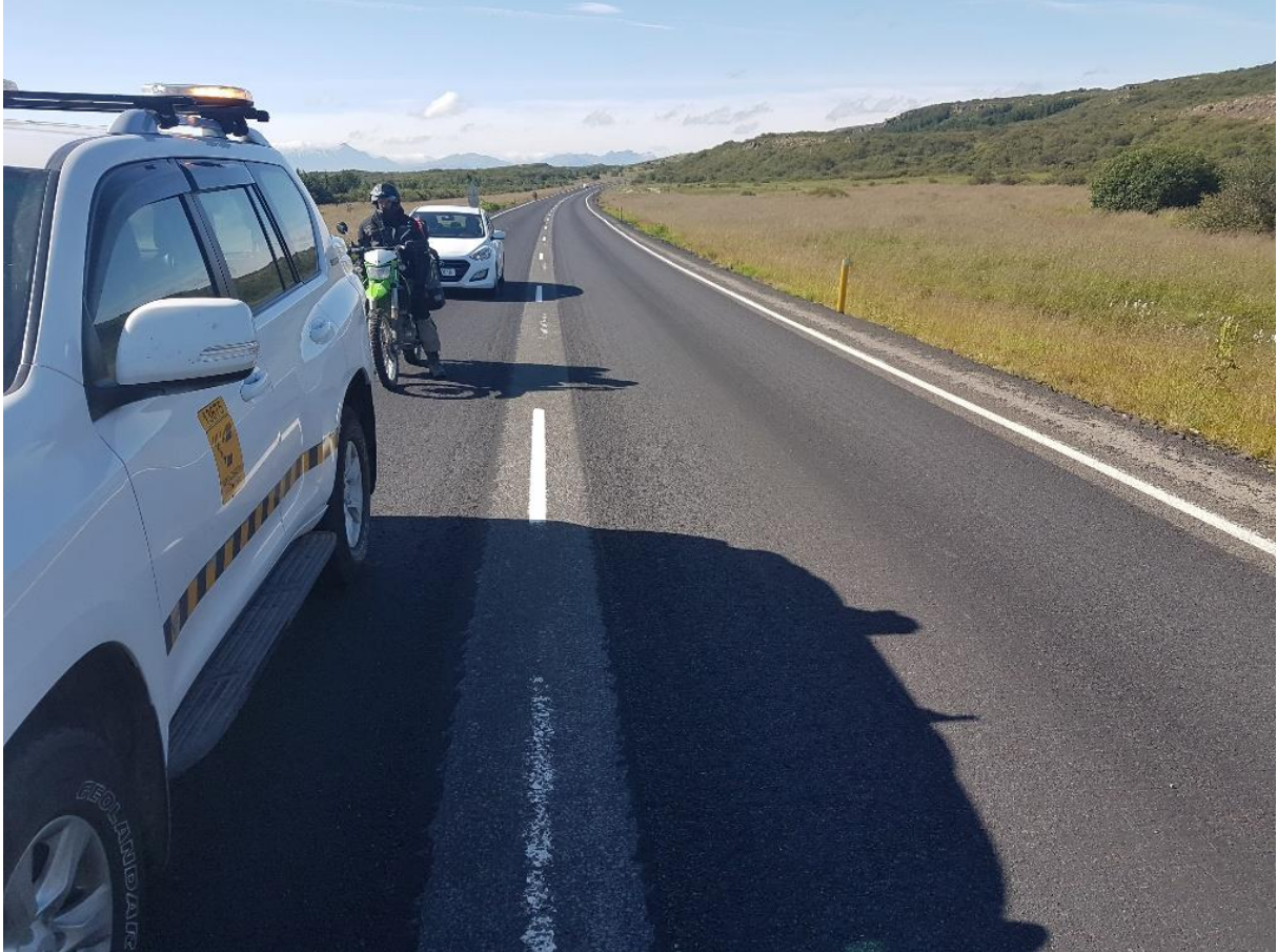
Mynd 1 Hér má sjá Ralumac afréttingu undir bikþeytuklæðingu á 1-h0
