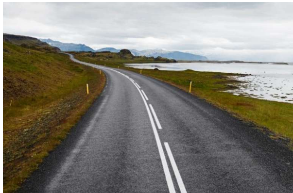
Mynd 6 Skýrar yfirborðsmerkingar, sem gjarnan duga einungis fram á vetur og eru mikið eyddar að vorir 22
