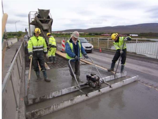
Mynd 5 Nýtt slitlag lagt á brú á Blöndu við Blönduós, steypa blönduð í steypubíl („trukkasteypa“) 13
