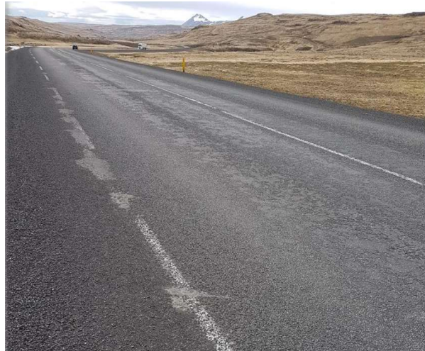
Mynd 1 Skemmdir eftir tönn snjóplógs 2
