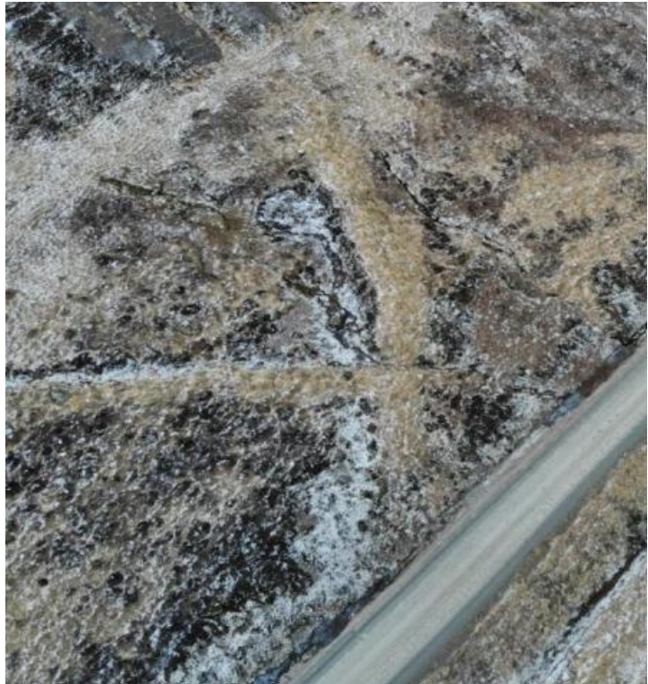
Mynd 123. Nútímalegt vatnsræsi þar sem járnþrútur voru sjáanlegar við endann.
