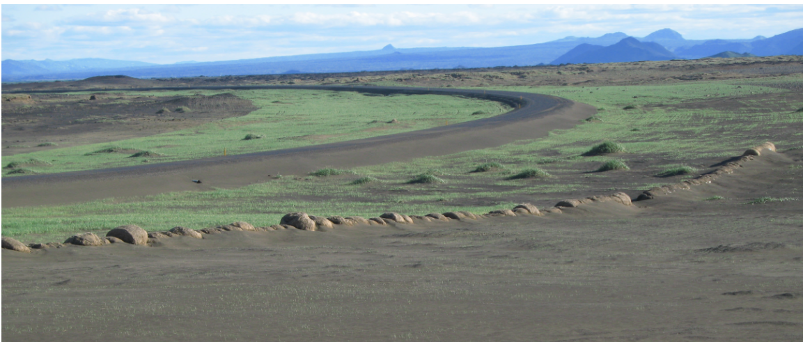
Mynd 6. Uppgræðsla með melgresi til að draga úr sandfoki við Dettifossveg.
