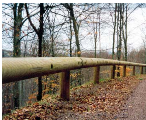
Mynd 8 “Miljørekkverk” frá Vikverk AS Noregi. Stálplata, 160 x 5 mm gengur eftir endilöngu vegriðinu.
