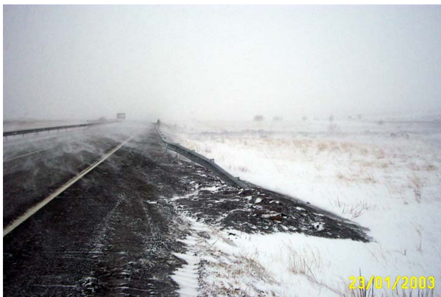
Mynd 11. Vegrið við hægri vegarkant austan Hólmsár. Ferill vegriðs er þannig í grófum dráttum að fyrstu 10 m frá brúnni eru samsíða vegi, næstu 35 m liggja skáhalt út frá vegi þannig að vegrið gengur u.þ.b. 1 m út frá upprunalegri línu og á síðustu 10 m er vegrið fært niður í fyllingu og vikur um 2 m til viðbótar frá vegi. Vegriðsendinn er því í 4 m fjarlægð frá kantlínu vegar. Talið er að þetta fyrirkomulag muni minnka snjósöfnun inn á veginn og auðvelda snjóhreinsun.
