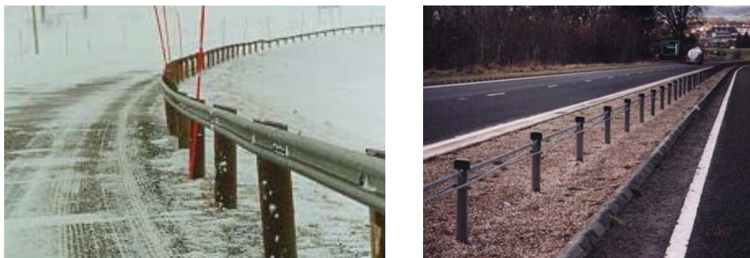
Mynd 6. Vinstri: Vegrið af Kohlswa-gerð. Hægri: Víravegrið. (RoadEx, 2001)
