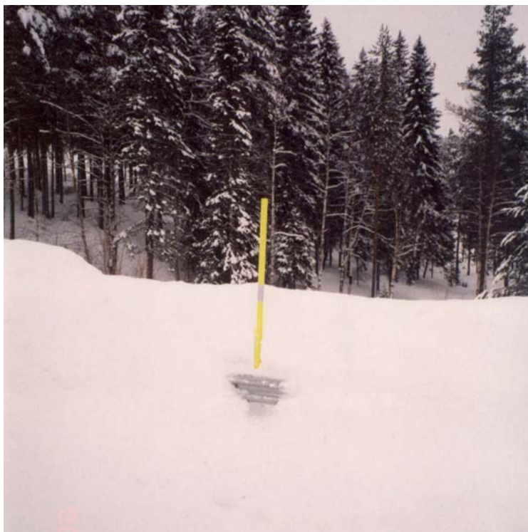
Mynd 1. Dæmi um það þegar mikil snjódýpt á landinu í kring veldur því að vegrið grefst í snjó, þó að það hafi aðeins 160 mm háan prófil (“Kohlswa”) og ætti því að vera heppilegt gegn skafrenningi (RoadEx, 2001).
