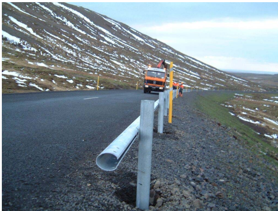
Mynd 12. Unnið við uppsetningu Sicuro röravegriðs á Vatnaleið á Snæfellsnesi. Hér er annað rörið af tveimur komið á réttan stað.
