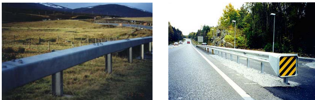
Mynd 7. Vinstri: Kassalaga vegriðsbiti (RoadEx, 2001). Hægri: Vegriðsendi með ákeyrsluöryggi, ABC-Terminalen (Euroskilt AS)
