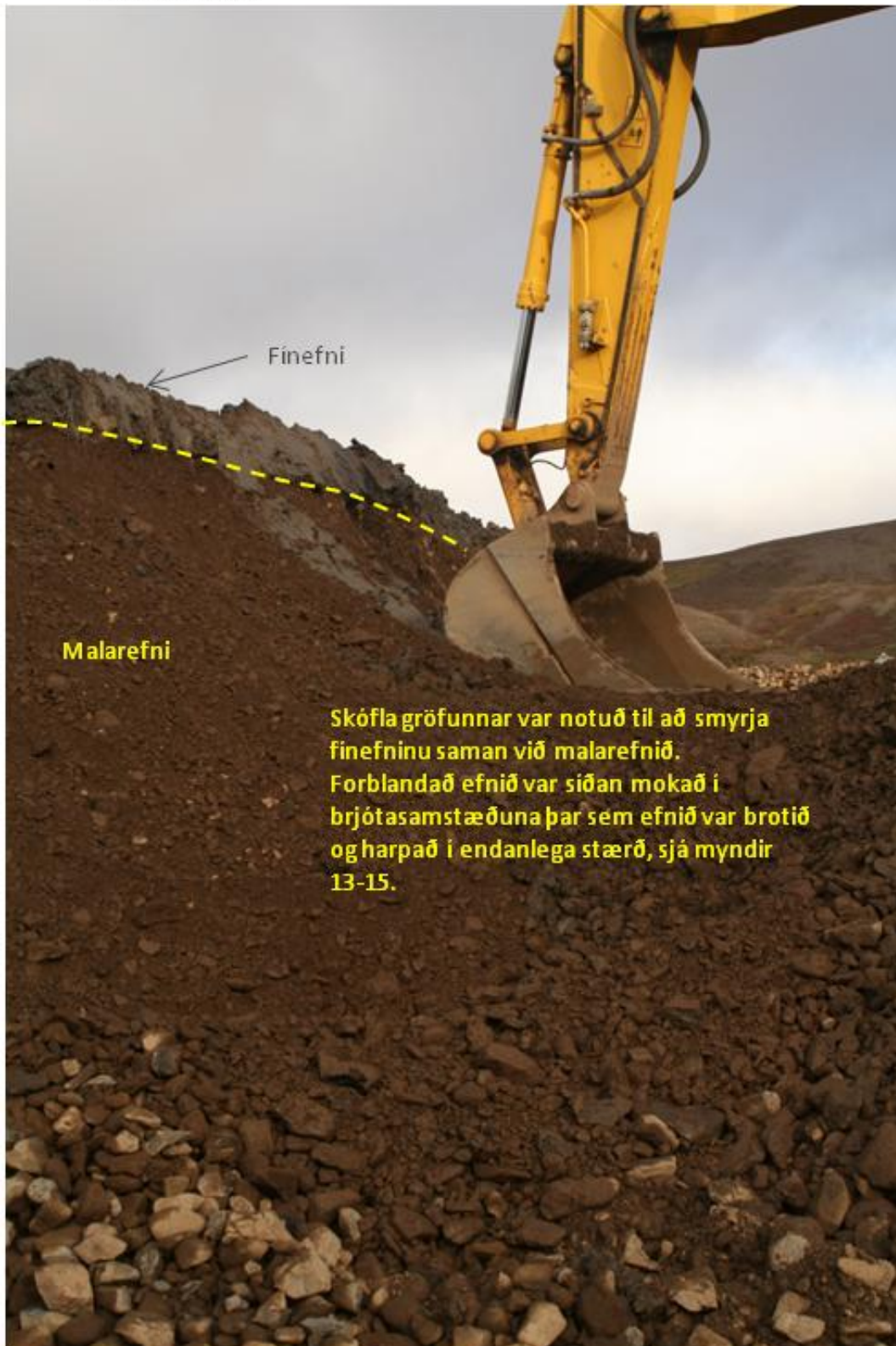
Mynd 14: Myndin er tekin við forblöndun þegar fínefni var blandað saman við forbrotið malarslitlagsefni. Á myndinni sést fínefnislag ofan á malarefninu og hvernig skófla gröfunnar var notuð til að smyrja því niður og síðan blandað saman við malarefnið. Malarefnið var uppdælt og brotið af staðnum úr Dælisá og fínefnið var sótt að Hálsenda í Kjós.
